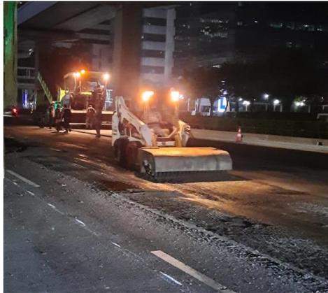
**Gambar 3. 13 Proses Pembersihan Area Menggunakan Bobcat Sweeper**
