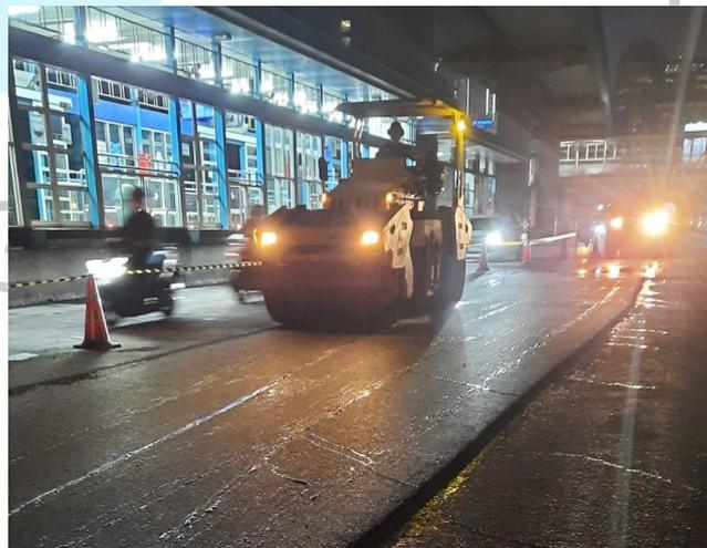
**Gambar 3. 18 Proses Pepadatan Aspal Hotmix menggunakan alat Tandem Rollers**
