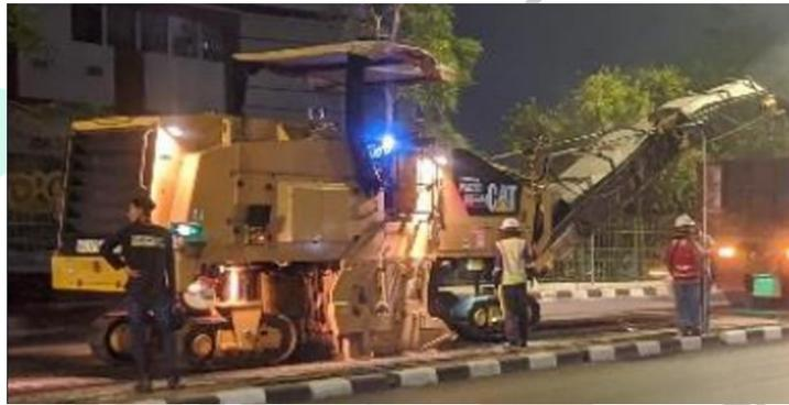
**Gambar 3. 12 Proses *Scraping* Menggunakan *Cold Milling Machine***
