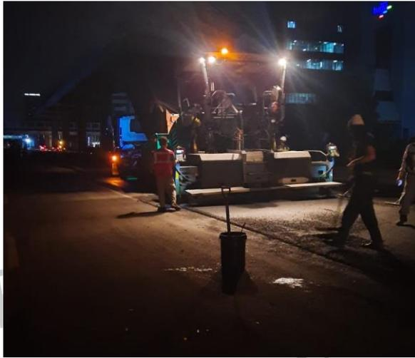
**Gambar 3. 16 Proses Penghamparan AC-BC menggunakan Alat Asphalt Finisher**
