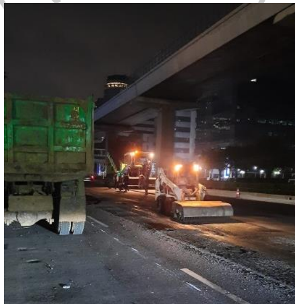
Lampiran 1. 2 Proses Pembersihan Area Menggunakan Bobcat Sweeper
