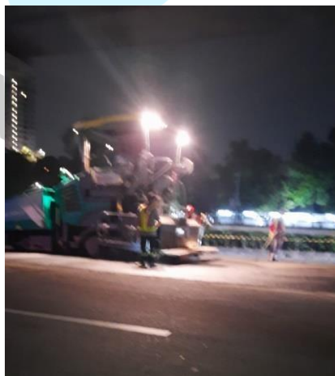
Lampiran 1. 3 Proses Penghamparan AC-BC menggunakan Alat Asphalt Finisher
