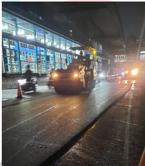
Lampiran 1. 5 Proses Pemadatan Aspal Hotmix menggunakan alat Tandem Rollers
