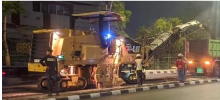
Lampiran 1. 1 Proses Scrapping Menggunakan Cold Milling Machine
