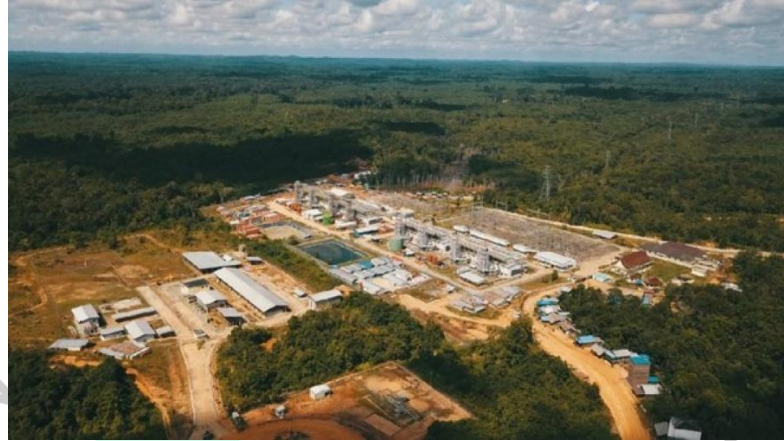
Gambar 2. 10 PLTMG Bangkanai (Sumber: PT. Jaya CM)
