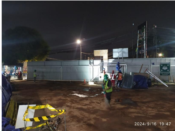
Gambar 3. 47 Penyiraman Lokasi Proyek
