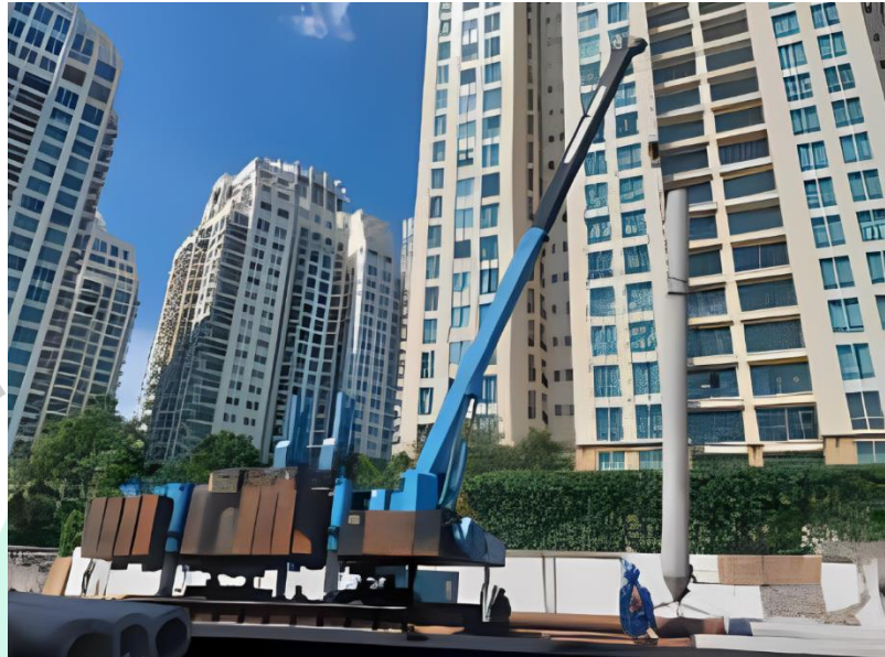
Gambar 3. 27 Penempatan Tiang Pancang
