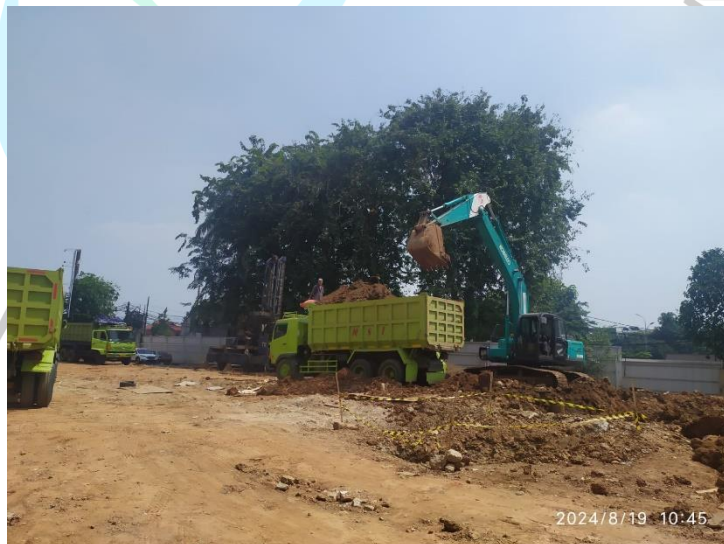
Gambar 3. 45 Muatan Tanah ke Dalam Dump Truck
