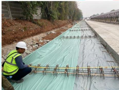
Gambar 2. 7 Checklist Ukuran Dowel Pada Pekerjaan Rigid Pavement
