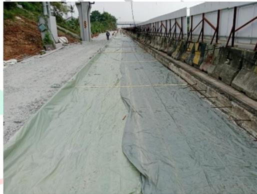
**Gambar 3. 29** Pekerjaan Pemasangan *Bekisting Rigid Pavement*
