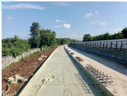
**Gambar 3. 28** Pekerjaan Pemasangan *Plastic Sheet*
