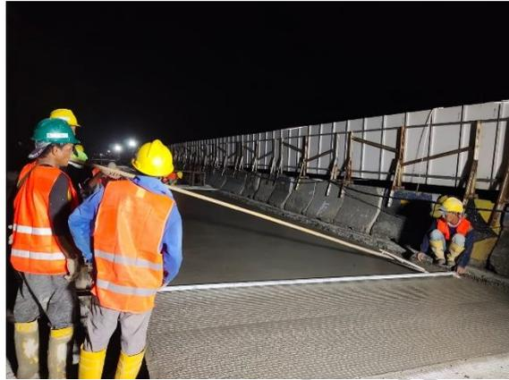
**Gambar 3. 34** Tahapan Pekerjaan *Finishing* dan *Grooving*
