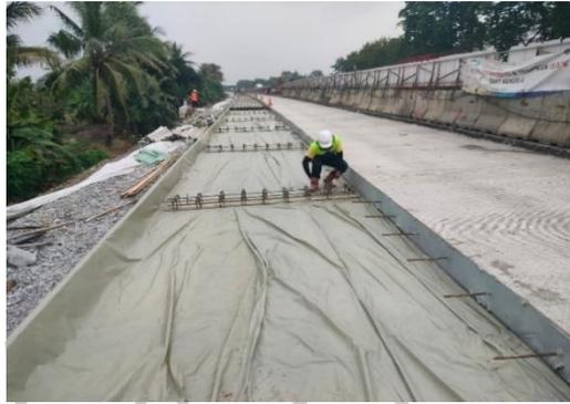
**Gambar 3. 30** Proses Tahapan Pekerjaan Pemasangan besi *Dowel, Tie Bar* dan *Crack Inducer*
