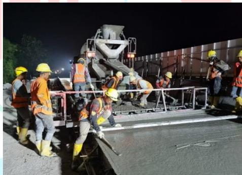
**Gambar 3. 33** Tahapan Pekerjaan Perataan Permukaan
