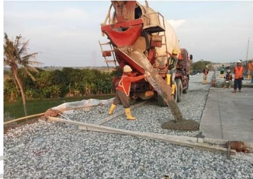
**Gambar 3. 25** Proses Pengecoran Beton Pada Pekerjaan *Lean Concrete*
