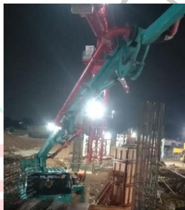
Gambar 3. 23 Concrete Pump (Sumber; Dokumentasi Pribadi, 2024)
