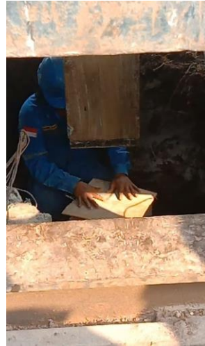
Gambar 3. 43 Perataan Kepala Tiang (Sumber; Dokumentasi Pribadi, 2024)
