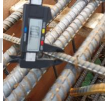
Gambar 3. 53 Pengecekan Pekerjaan Pembesian Pile Cap (Sumber; Dokumentasi Pribadi, 2024)
