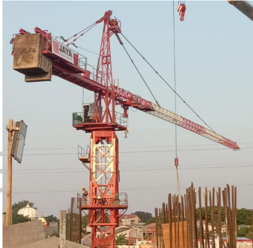
Gambar 3. 17 Tower Crane (Sumber; Dokumentasi Pribadi, 2024)
