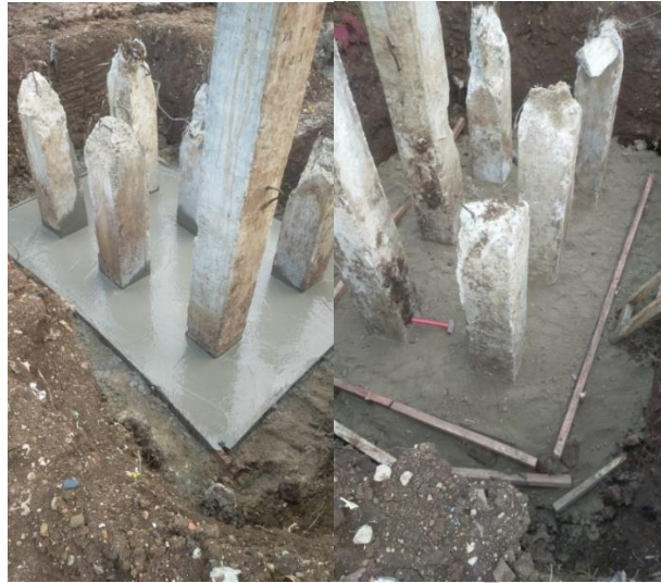
Gambar 3. 51 Pekerjaan Pasir Urug dan Lantai Kerja
