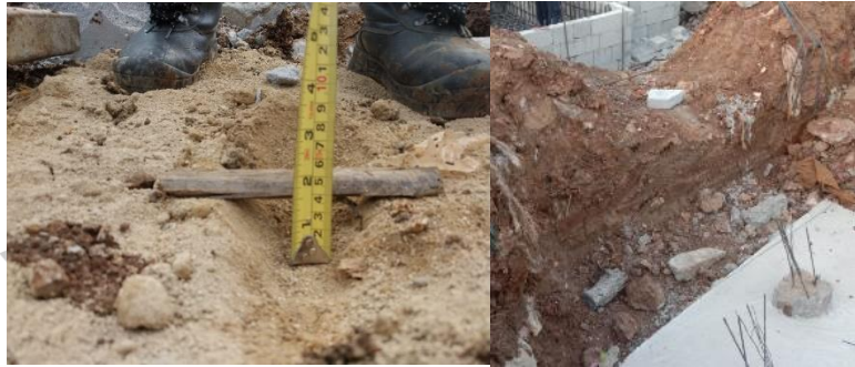
Gambar 3. 58 Pekerjaan Galian Tie Beam (Sumber; Dokumentasi Pribadi, 2024)
