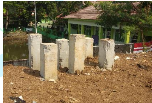
Gambar 3. 40 Hasil Proses Pemancangan (Sumber; Dokumentasi Pribadi, 2024)
