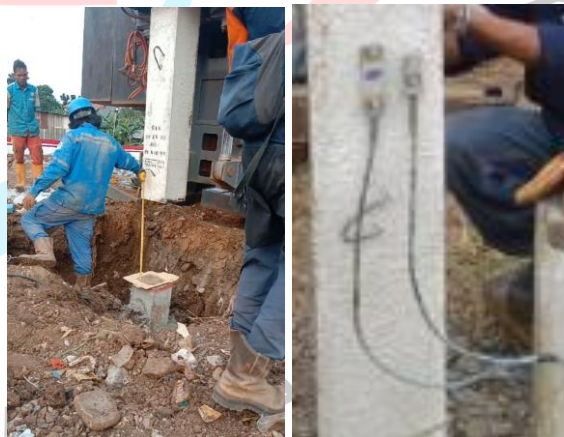
Gambar 3. 44 Penempatan Strain Transducer dan Accelerometer (Sumber; Dokumentasi Pribadi, 2024)
