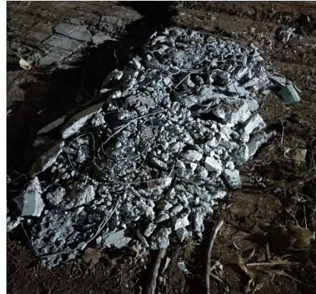
Gambar 3. 39 Pemotongan Kelebihan Tiang Pancang (Sumber; Dokumentasi Pribadi, 2024)
