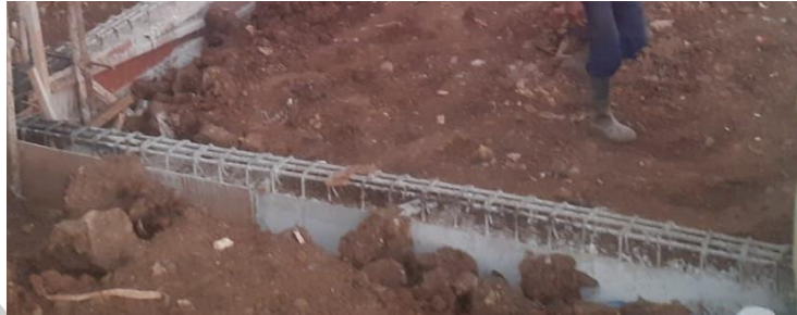
Gambar 3. 63 Hasil Pembukaan Bekisting Tie Beam (Sumber; Dokumentasi Pribadi, 2024)
