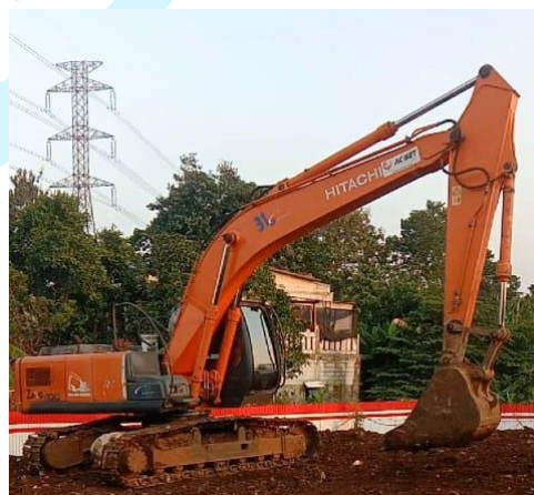
Gambar 3. 22 Excavator (Sumber; Dokumentasi Pribadi, 2024)
