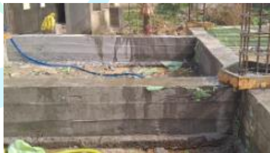
Gambar 3. 64 Perawatan Beton Tie Beam (Sumber; Dokumentasi Pribadi, 2024)
