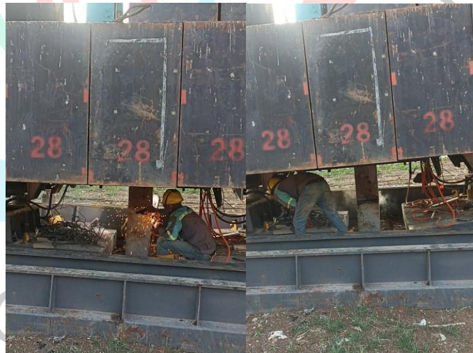
Gambar 3. 37 Pengelasan Sambungan Bagian Bottom dan Upper (Sumber; Dokumentasi Pribadi, 2024)
