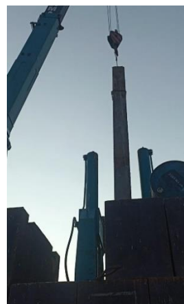
Gambar 3. 36 Pemancangan Bagian Upper (Sumber; Dokumentasi Pribadi, 2024)
