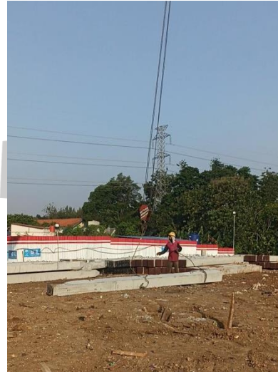
Gambar 3. 34 Pengangkatan Tiang Pancang (Sumber; Dokumentasi Pribadi, 2024)
