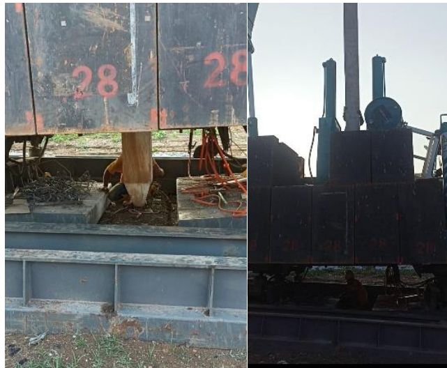
Gambar 3. 35 Pemancangan Bagian Bottom (Sumber; Dokumentasi Pribadi, 2024)
