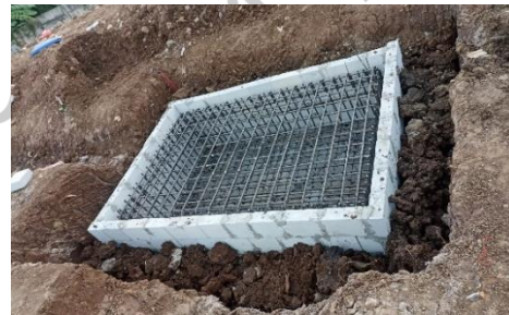
Gambar 3. 54 Pemasangan Bekisting Pile Cap (Sumber; Dokumentasi Pribadi, 2024)
