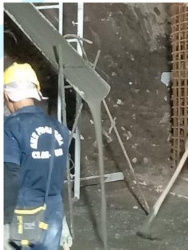
Gambar 3. 27 Beton Ready Mix (Sumber; Dokumentasi Pribadi, 2024)
