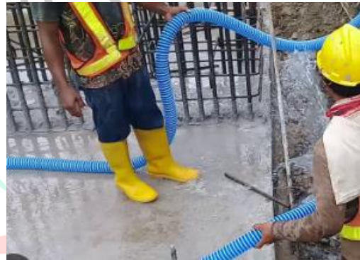
Gambar 3. 56 Perawatan Beton Pile Cap (Sumber; Dokumentasi Pribadi, 2024)
