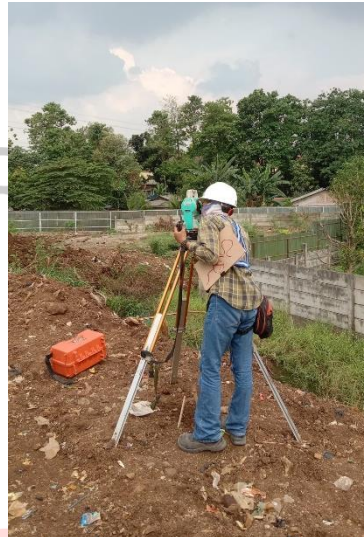
Gambar 3. 33 Pengoperasian Total Station (Sumber; Dokumentasi Pribadi, 2024)
