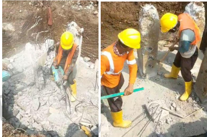
Gambar 3. 52 Pekerjaan Pembobokan Tiang Pancang (Sumber; Dokumentasi Pribadi, 2024)
