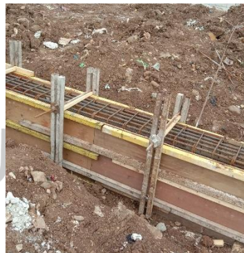
Gambar 3. 61 Bekisting Tie Beam (Sumber; Dokumentasi Pribadi, 2024)
