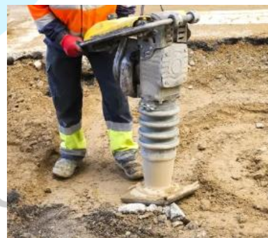
Gambar 3. 13 Tamping Ramer (Sumber; Dokumentasi Pribadi, 2024)
