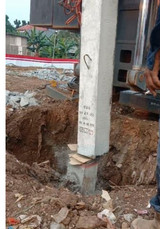
Gambar 3. 45 Penumbukan Kepala Tiang (Sumber; Dokumentasi Pribadi, 2024)
