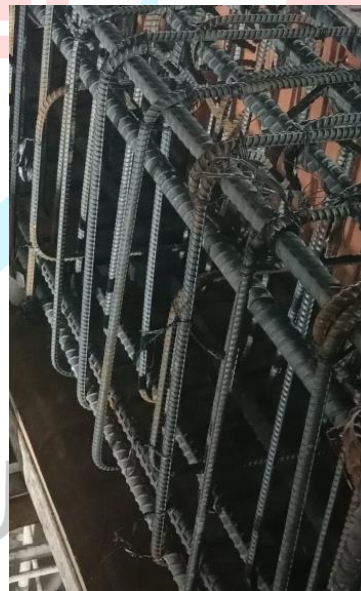
Gambar 3. 59 Pembesian Tie Beam (Sumber; Dokumentasi Pribadi, 2024)
