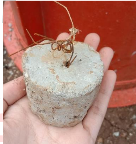
Gambar 3. 28 Beton Decking (Sumber; Dokumentasi Pribadi, 2024)
