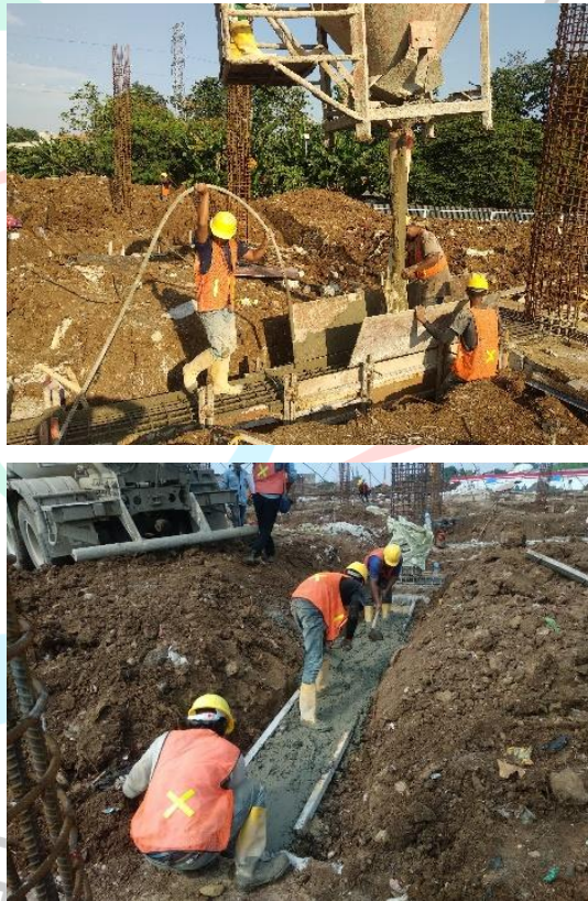
Gambar 3. 62 Pengecoran Tie Beam (Sumber; Dokumentasi Pribadi, 2024)
