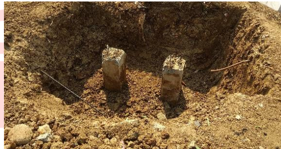
Gambar 3. 42 Penggalian Tiang Pancang Sedalam 1 m (Sumber: Dokumentasi Pribadi, 2024)
