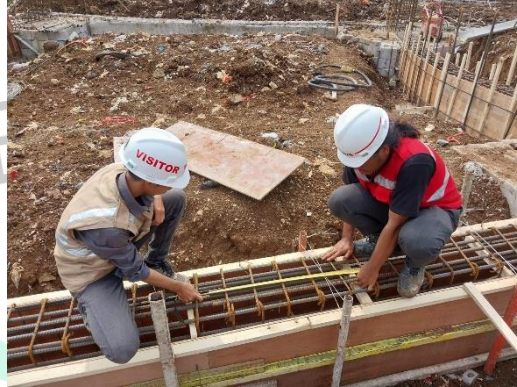
Gambar 3. 60 Pengecekan Pekerjaan Pembesian Tie Beam (Sumber; Dokumentasi Pribadi, 2024)
