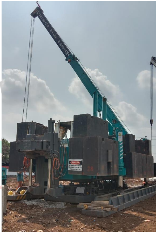
Gambar 3. 15 Jacking Pile (Sumber; Dokumentasi Pribadi, 2024)
