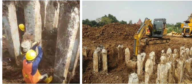
Gambar 3. 50 Pekerjaan Galian Pile Cap (Sumber; Dokumentasi Pribadi, 2024)
