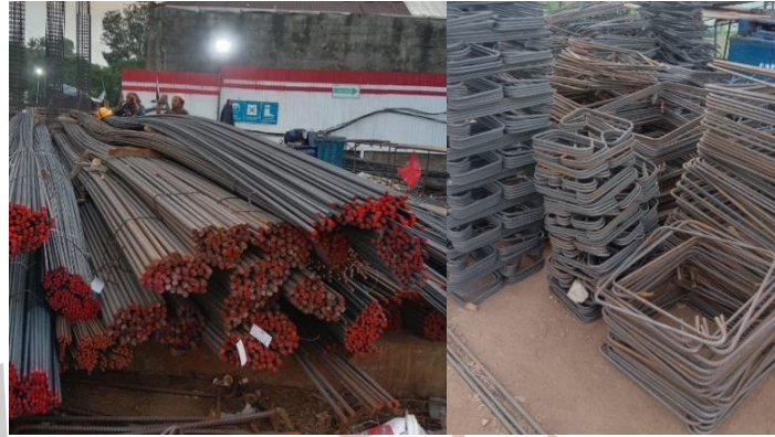
Gambar 3. 24 Besi Tulangan (Sumber; Dokumentasi Pribadi, 2024)
