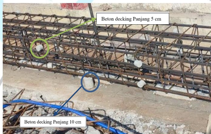
Gambar 3.26 Pemasangan Beton Decking
