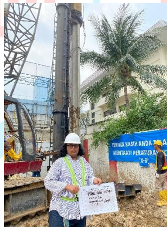
Gambar 3.16 Tagging Pemancangan CCSP
