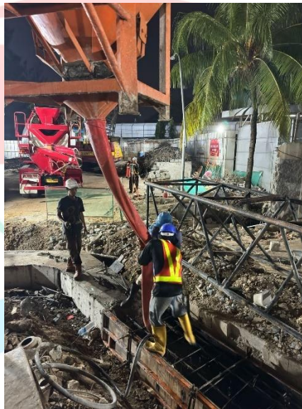
Gambar 3.29 Proses Pengecoran
