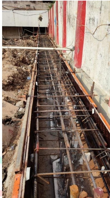
Gambar 3.27 Pemasangan Bekisting
