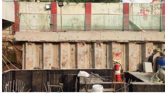
Gambar 3.30 Setelah pelepasan Capping Beam
