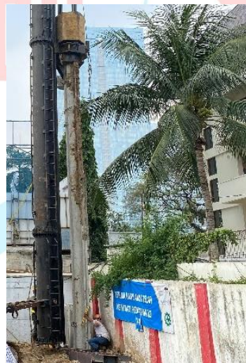
Gambar 3.18 Pengecekan kelurusan
