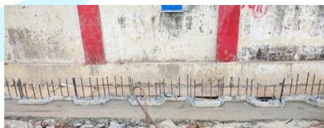
Gambar 3.22 Cor Lantai Kerja
