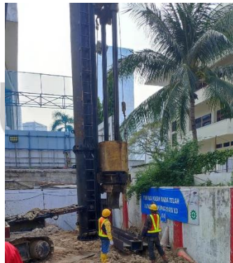
Gambar 3.10 Pemasangan Guide Beam
