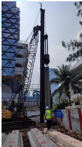
Gambar 3.13 Proses persiapan pemasangan Drive Cap
