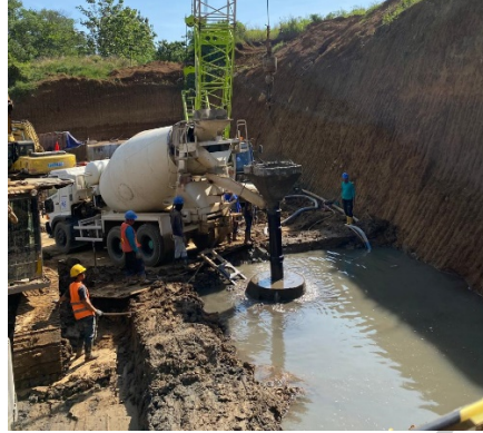
Gambar 3. 51 Proses Pengecoran Dengan Pipa Tremi (Sumber : Dokumentasi Pribadi)
