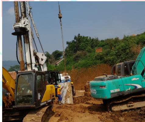
Gambar 3. 45 Tahap Pemasangan Casing (Sumber : Dokumentasi Pribadi)
