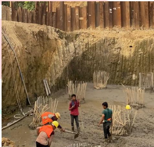
Gambar 3. 56 Pengecoran Lean Concrete (Sumber : Dokumentasi Pribadi)
