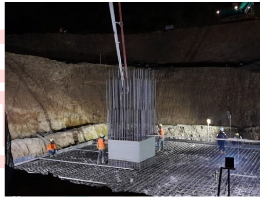
Gambar 3. 61 Proses Pengecoran Layer 1,2,3 (Sumber : Dokumentasi Pribadi)
