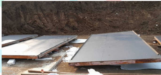
Gambar 3. 17 Bekisting (Sumber : Dokumentasi Pribadi)
