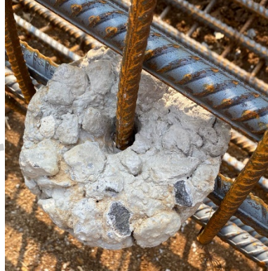
Gambar 3. 16 Beton Decking (Sumber : Dokumentasi Pribadi)
