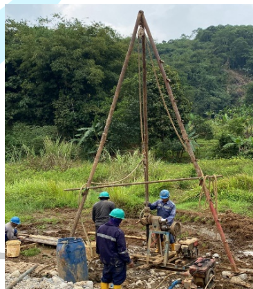
Gambar 3. 42 Pengujian Bor Log (Sumber : Dokumentasi Pribadi)
