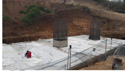
Gambar 3. 63 Pemasangan Styrofoam dan Geotekstil (Sumber : Dokumentasi Pribadi)
