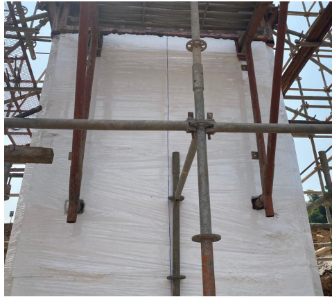
Gambar 3. 18 Styrofoam dan Lapisan Plastik (Sumber : Dokumentasi Pribadi)
