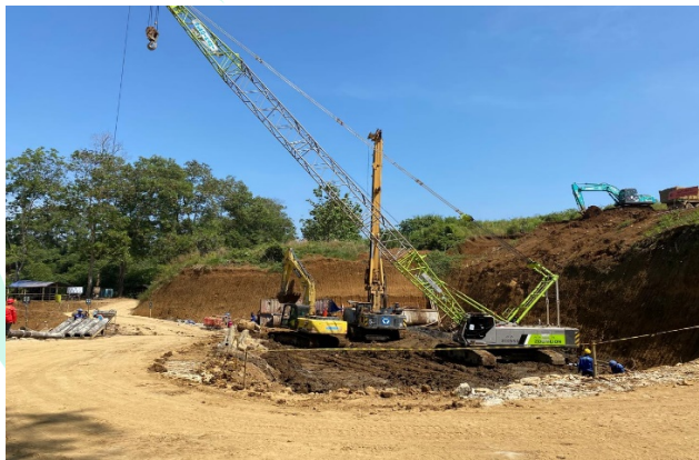
Gambar 3. 32 Crawler Crane Cibodas (Sumber : Dokumentasi Pribadi)
