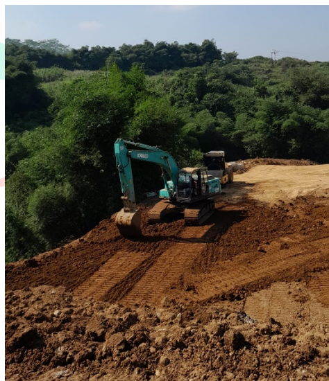
Gambar 3. 29 Excavator (Sumber : Dokumentasi Pribadi)
