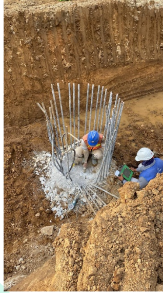
Gambar 3. 36 Pengujian Pile Inetgrity Test (Sumber : Dokumentasi Pribadi)
