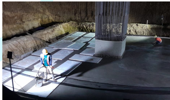
Gambar 3. 62 Proses Penyiraman Curing Compound (Sumber : Dokumentasi Pribadi)
