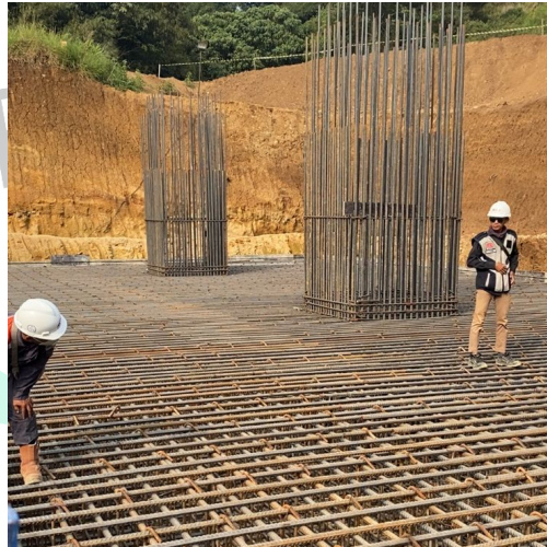
Gambar 3. 59 Checklist Tulangan Pile Cap JU Cimunjul (Sumber : Dokumentasi Pribadi)
