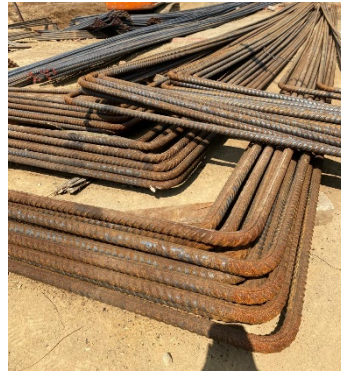
Gambar 3. 57 Besi Ulir D32 (Sumber : Dokumentasi Pribadi)
