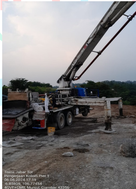
Gambar 3. 31 Concrete Pump (Sumber : Dokumentasi Pribadi)
