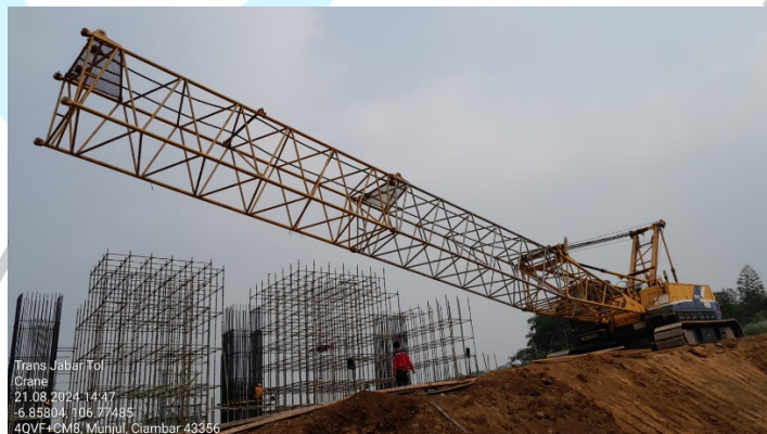
Gambar 3. 33 Crawler Crane Cimunjul (Sumber : Dokumentasi Pribadi)
