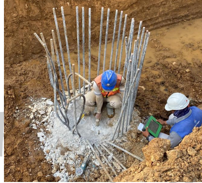
Gambar 3. 52 Pengujian PIT Test (Sumber : Dokumentasi Pribadi)
