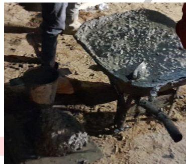
Gambar 3. 60 Proses Slump Test (Sumber : Dokumentasi Pribadi)
