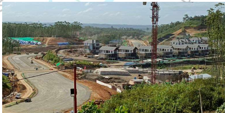
Gambar 2. 6 Proyek Pembangunan Jalan Sumbu Kebangsaan Sisi Barat
