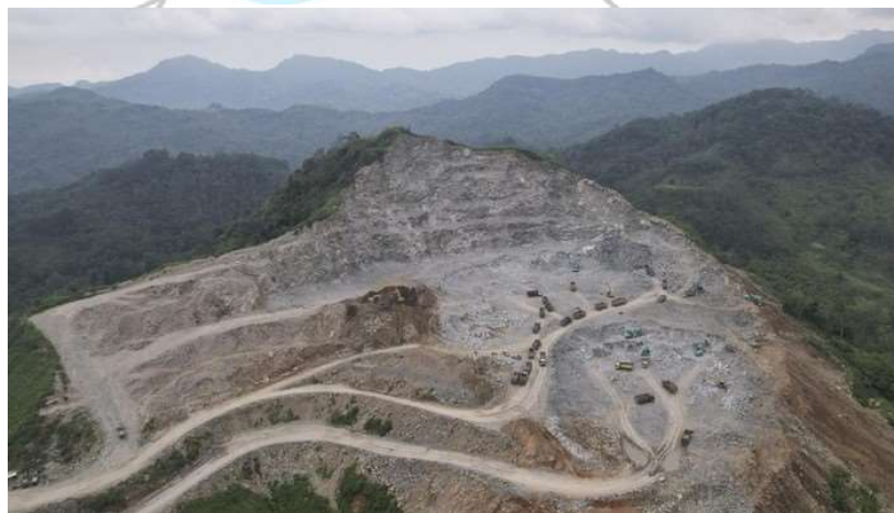
Gambar 2. 8 Proyek Pembangunan Bendungan Leuwikeris (Sumber: finance.detik.com, 2024)
