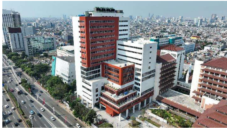
Gambar 2. 7 Proyek Pembangunan Rumah Sakit Dharmais (Sumber: Tempo.co, 2024)
