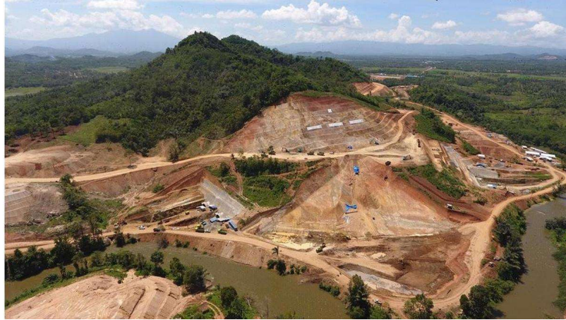
Gambar 2. 5 Proyek Pembangunan Bendungan Way Sekampung (Sumber: Liputan6.com, 2024)
