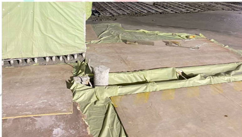
Gambar 3. 54 Proses curing pada beton raft (Sumber: Dokumentasi Pribadi, 2024)
