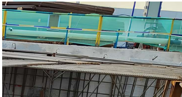
Gambar 3. 28 Pagar Kerja pada Proyek (Sumber: Dokumentasi Pribadi, 2024)
