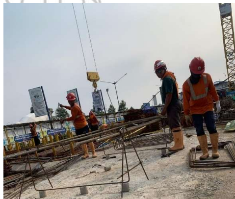
Gambar 3. 40 Tahap Fabrikasi Pembesian (Sumber: Dokumentasi Pribadi, 2024)
