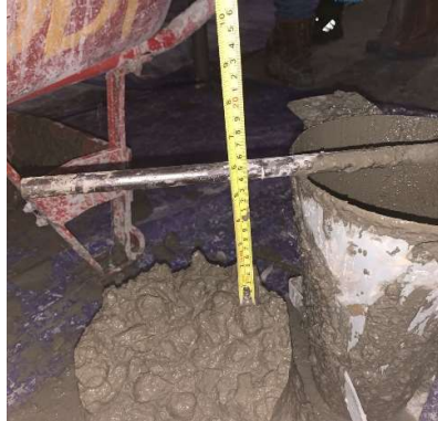
Gambar 3. 49 Pengecekan slump pada sampel beton (Sumber: Dokumentasi Pribadi, 2024)
