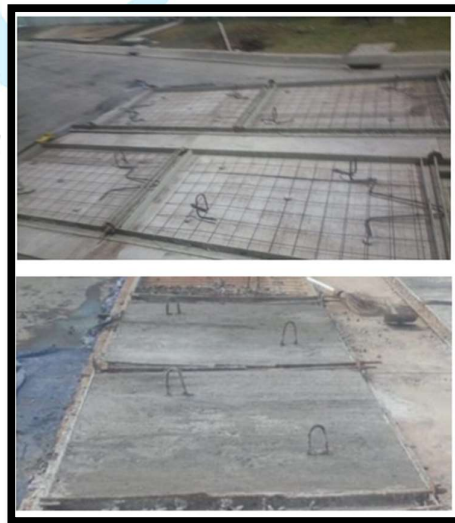
Gambar 3. 21 Bekisting Precast untuk Pile Raft Foundation (atas sebelum dicor, bawah setelah dicor)
