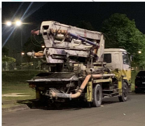
Gambar 3. 7 Concrete Pump (Sumber: Dokumentasi Pribadi, 2024)
