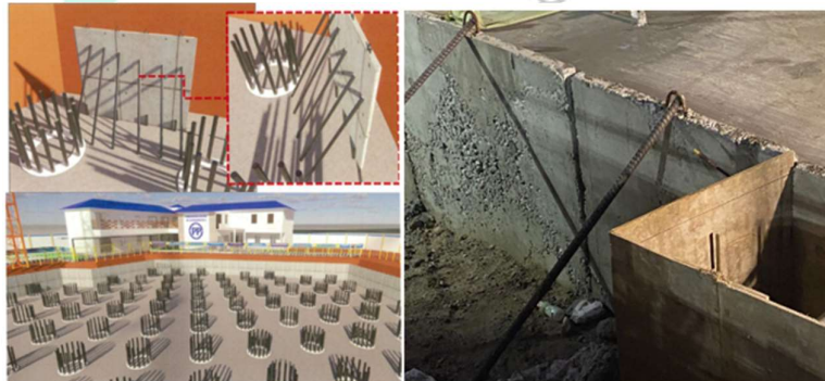
Gambar 3. 38 Detail dan Penampakan Bekisting Pile Raft Foundation Setelah Dipasang Pada Tempat Galian
