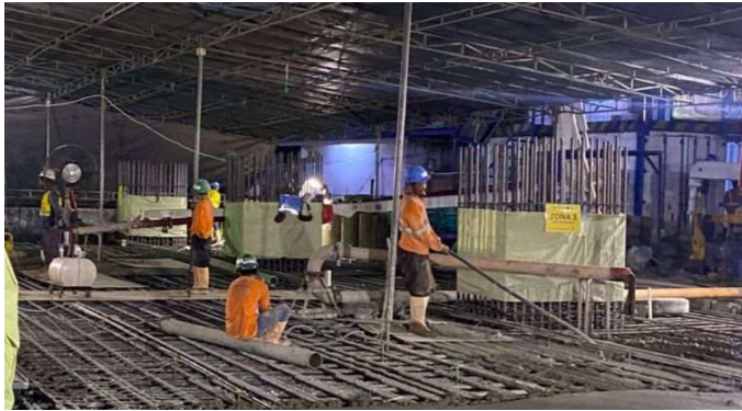
Gambar 3. 53 Pengecoran dengan Concrete Pump (Sumber: Dokumentasi Pribadi, 2024)
