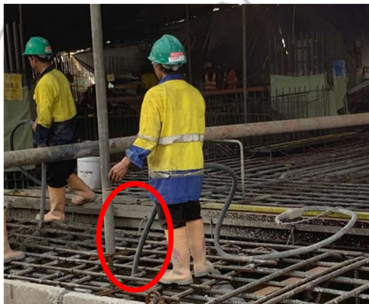
Gambar 3. 51 Pengecoran dengan Vibrator
