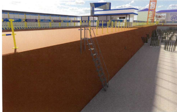
Gambar 3. 29 Tangga Akses Kerja pada Proyek (Sumber: Dokumen Pekerjaan PP BNI PIK 2, 2024)
