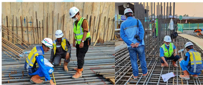
Gambar 3. 55 Proses Pengecekan Pembesian pada Pile Raft Foundation
