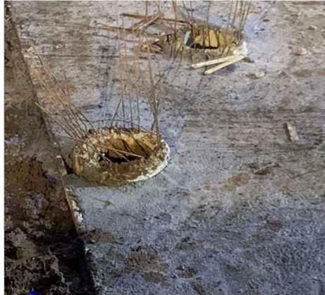
Gambar 3. 32 Penampakan Setelah Diberikan Urugan pasir dan Lean Concrete
