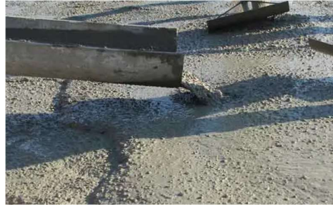
Gambar 3. 16 Beton Mix (Sumber: Dokumentasi Pribadi, 2024)
