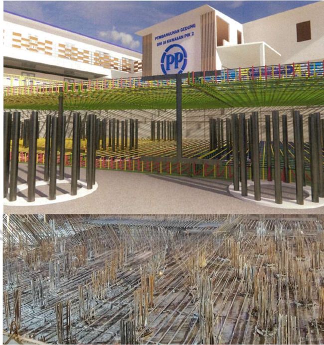
Gambar 3. 43 Pembesian Pile Raft Foundation (Sumber: Dokumentasi Pribadi, 2024)
