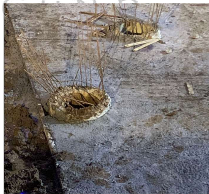
Gambar 3. 34 Penampakan Pembesian dan Plat Tiang Pancang
