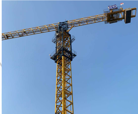
Gambar 3. 6 Tower Crane (Sumber: Dokumentasi Pribadi, 2024)
