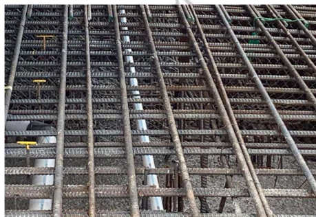
Gambar 3. 15 Besi Beton (Sumber: Dokumentasi Pribadi, 2024)
