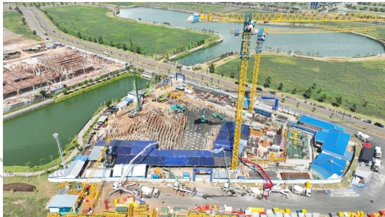
Gambar 3. 47 Pengecoran Pada Proyek BNI PIK 2 (Sumber: Dokumentasi Pribadi, 2024)
