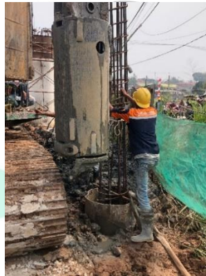
Gambar 3.15 Pembesian tulangan Bored Pile
