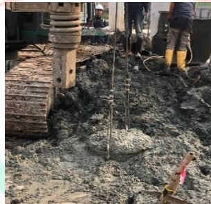
Gambar 3.19 Pelepasan temporary casing setelah pengecoran selesai dilaksanakan
