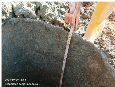
Gambar 3.14 Pengukuran kedalaman elevasi menggunakan meteran
