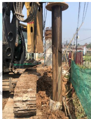
Gambar 3.12 Proses Pekerjaan Pengeboran
