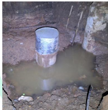
Gambar 3.22 proses grouting untuk dilakukan pengujian PIT dan PDA
