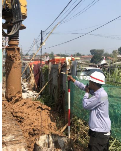
Gambar 3.5 Pengecekan Titik Koordinat
