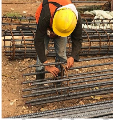
Gambar 3.7 Pembesian Tulangan Bored Pile
