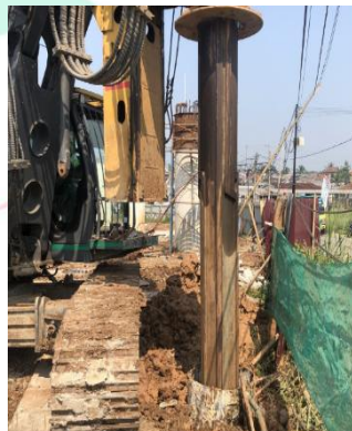
Gambar 3.13 Pembersihan Lubang Dasar Pondasi Bored Pile
