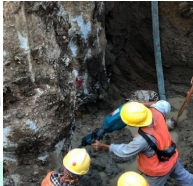
Gambar 3.21 proses pembobokan
