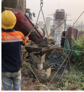
Gambar 3.18 Pengecoran area P9
