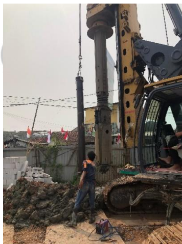
Gambar 3.16 Pemasangan Pipa Tremie
