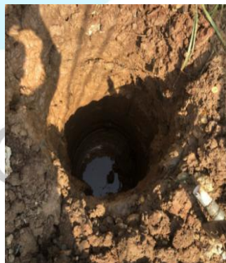
Gambar 3.10 Proses Pekerjaan Preboring
