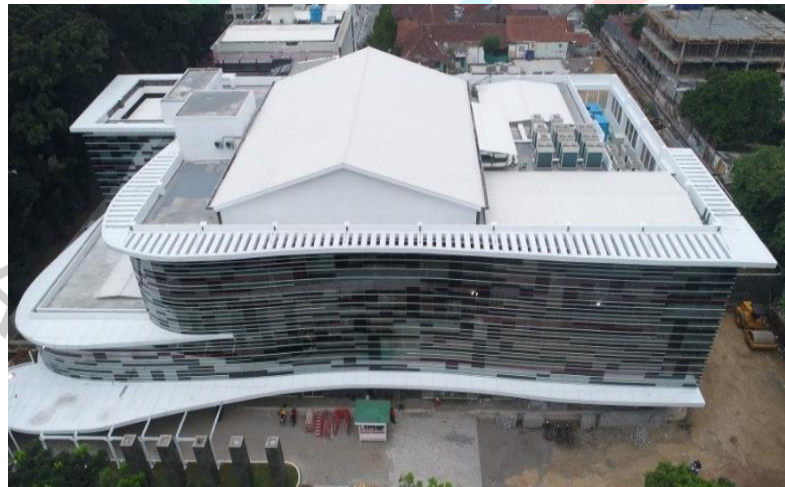
Gambar 2. 5 Rumah Sakit PMI Bogor (Sumber: Dokumen Pribadi PT. Adhi Persada Gedung)
