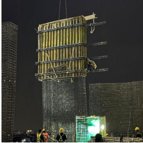
Gambar 3. 55 Pemasangan Bekisting Shear Wall
