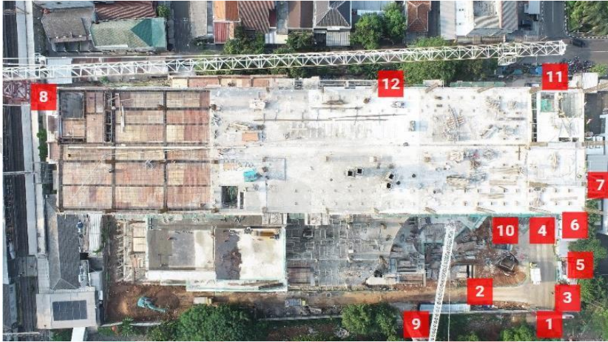
Gambar 3. 1 Site Management Proyek R.S Eka Hospital MT Haryono (Sumber : Dokumentasi Proyek PT. Adhi Persada Gedung, 2024)
