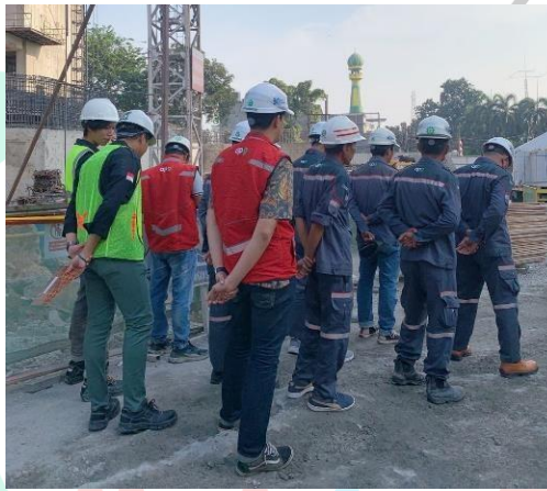
Gambar 3. 4 Safety Induction di Proyek Pembangunan Rumah Sakit Eka Hospital M.T. Haryono
