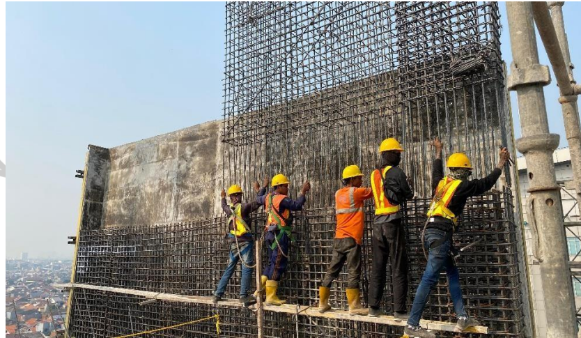
Gambar 3. 83 Pemasangan Pembesian Core Wall
