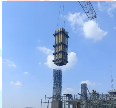
Gambar 3. 63 Pembongkaran Bekisting
