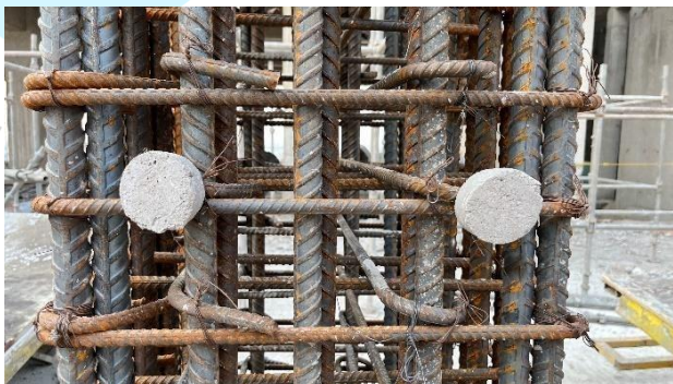
Gambar 3. 87 Pemasangan Beton Decking
