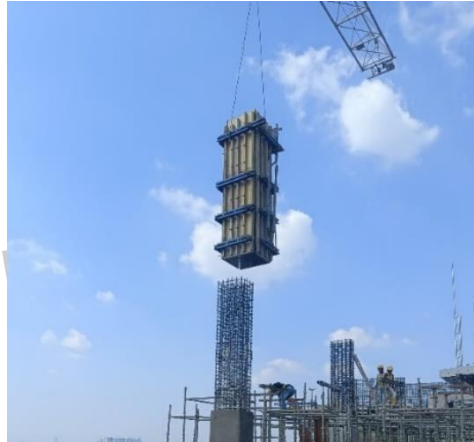
Gambar 3. 97 Pembongkaran Bekisting
