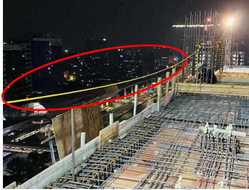
Gambar 3. 8 Lifeline di Proyek Pembangunan Eka Hospital M.T. Haryono
