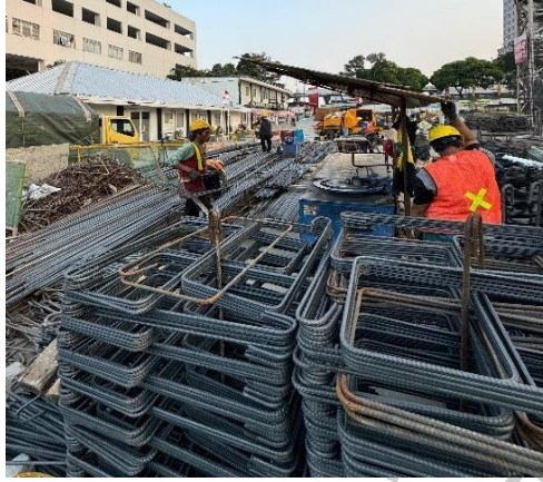
Gambar 3. 79 Persiapan Pembesian
