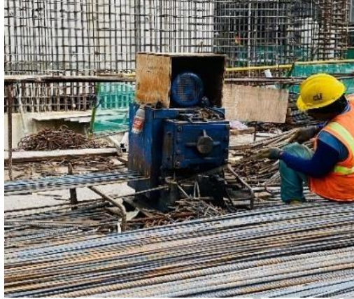
Gambar 3. 47 Fabrikasi Pembesian
