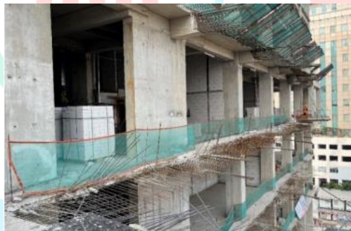
Gambar 3. 9 Safety Net di Proyek Pembangunan Eka Hospital M.T. Haryono
