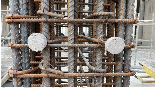
Gambar 3. 53 Pemasangan Beton Decking
