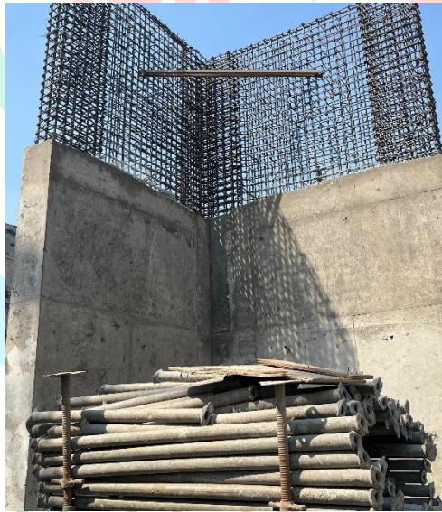
Gambar 3. 33 Shear Wall (Dinding Geser) pada Proyek Rumah Sakit Eka Hospital M.T Haryono
