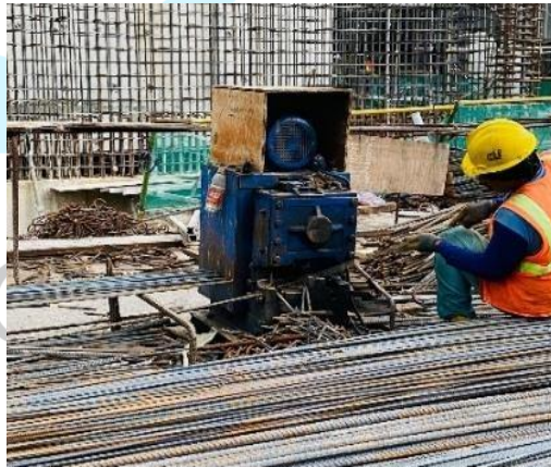
Gambar 3. 81 Fabrikasi Pembesian
