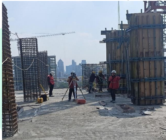
Gambar 3. 75 Survey Dan Marking
