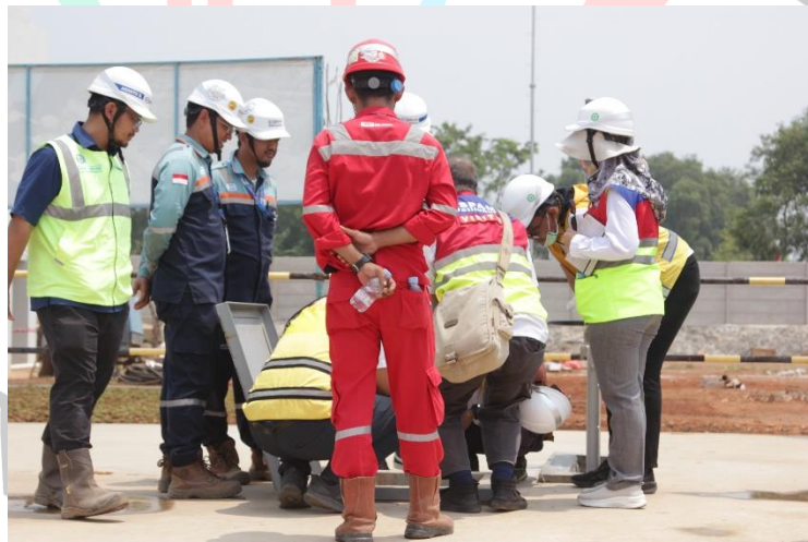
Gambar 3. 17 Pengecakan kondisi reservori IPA Cibeet (Sumber : Dokumentasi Proyek)
