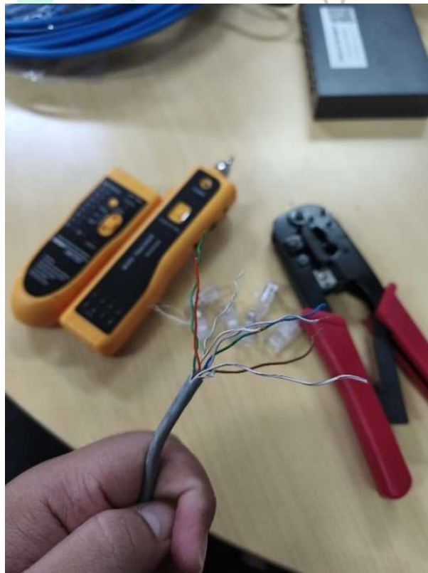
Gambar 3.20 Praktikan mengelupas kabel UTP
