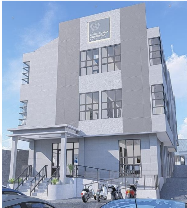
Gambar 2.2 Gedung Graha Pratama
