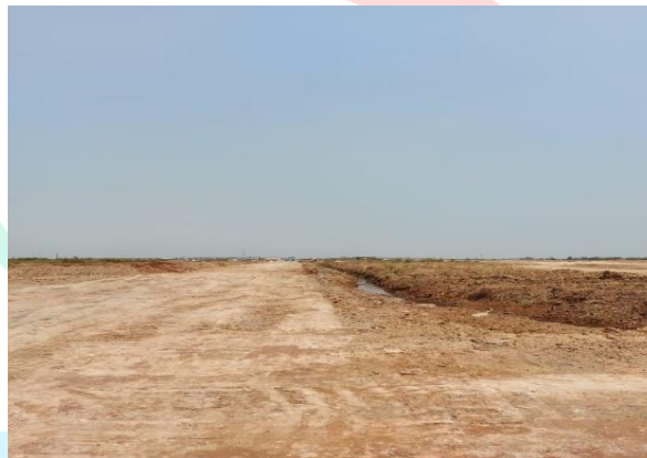
Gambar 3. 14 Pekerjaan Sub Grade (Dokumentasi Pribadi, 2023)
