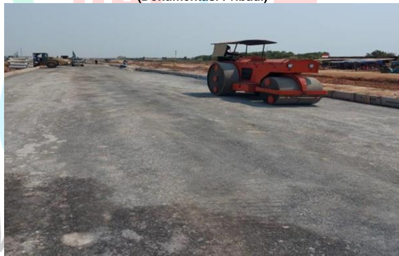
Gambar 3.20 Pekerjaan Sub Base Course menggunakan Lime Stones (Dokumentasi Pribadi, 2023)
