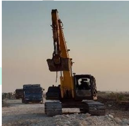
Gambar 3.5 Excavator (Dokumentasi Pribadi, 2023)
