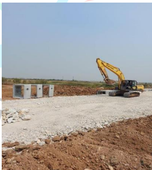
Gambar 3.17 Pekerjaan Sub Base Course menggunakan Lime Stone (Dokumentasi Pribadi, 2023)
