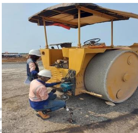
Gambar 3. 15 Pengujian Test CBR pada Sub Base Course (Dokumentasi Pribadi, 2023)
