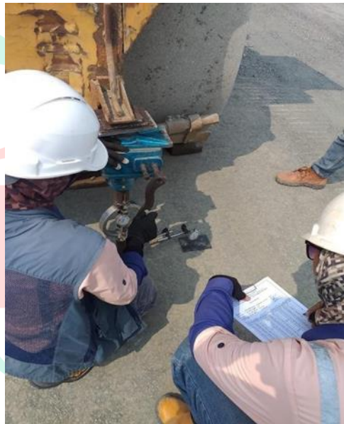
Gambar 3. 18 (Pengujian Test CBR Base Course) (Dokumentasi Pribadi)
