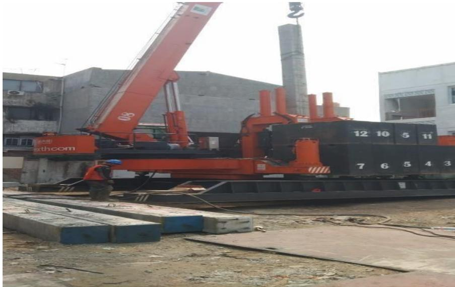
**Gambar 3. 14** Pengangkatan Tiang Pancang Menggunakan Crane
