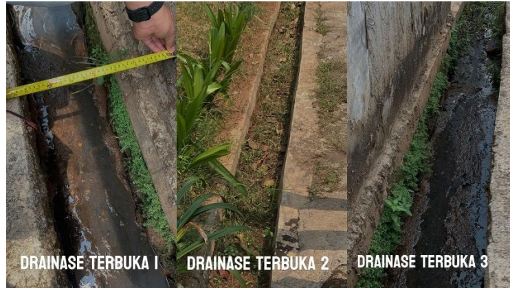
Gambar 4.4 Kondisi Saluran Drainase Terbuka (Dokumentasi Pribadi, 2024)
