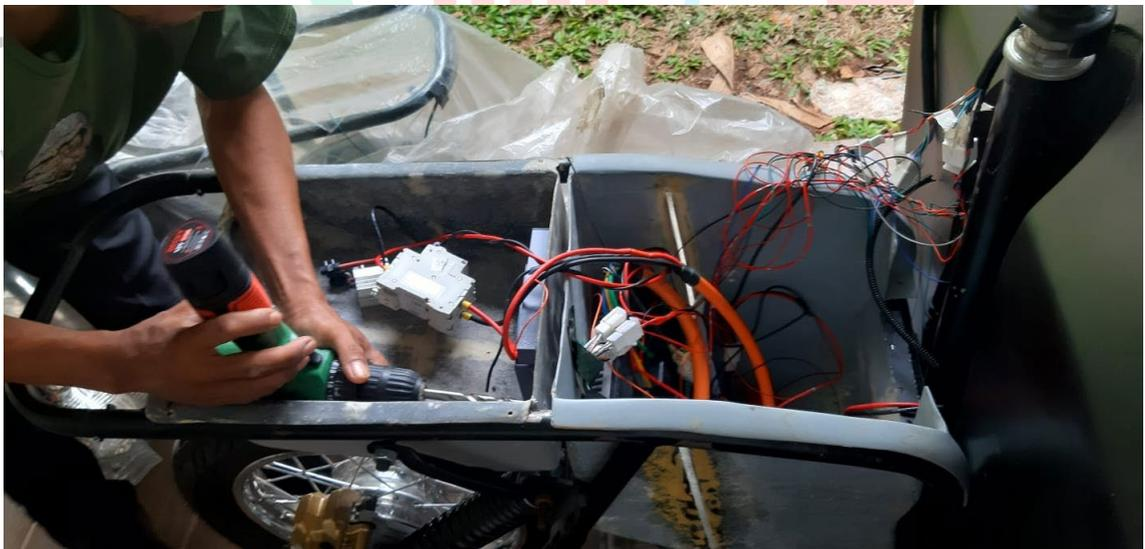
**Gambar 3. 26** Pengeboran pada Kerangka Cargo Bike
