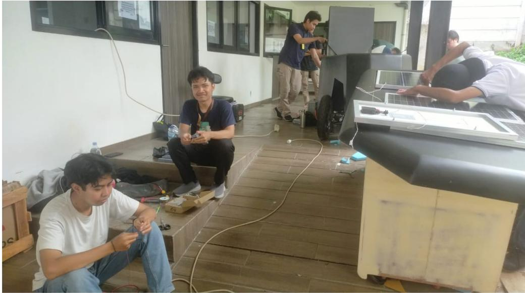
**Gambar 3. 29 Mengupas Kabel untuk Solar Panel**
