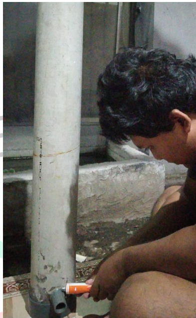
Gambar 4.13 Pemasangan Sok Drat (Dokumentasi Pribadi, 2024)
