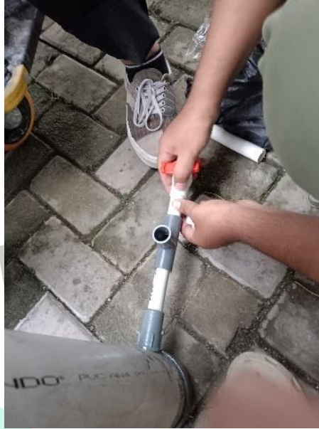
Gambar 4.11 Pipa paralon yang dilubangi (Dokumentasi Pribadi, 2024)
