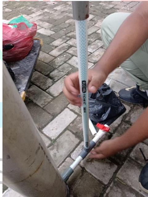
Gambar 4.12 Pemasangan paralon dengan Tee (Dokumentasi Pribadi, 2024)
