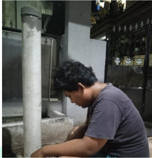
Gambar 4.15 Pemasangan dop pipa (Dokumentasi Pribadi, 2024)
