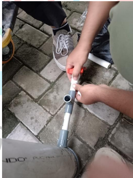
Gambar 4.14 Penyambungan Pipa dengan Sokdrat (Dokumentasi Pribadi, 2024)
