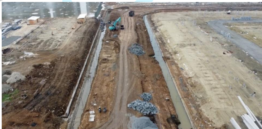
Gambar 4. 7 Progres Pekerjaan Galian
