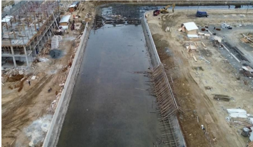
Gambar 4. 6 Progres Pembangunan Danau EDU CITY PIK
