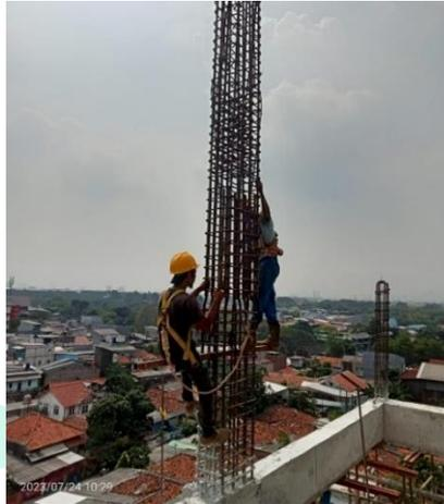
**Gambar 3. 61 Proses Penyambungan Tulangan Kolom**
