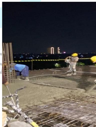
**Gambar 3. 51 Proses Pemadatan Beton Segar**
