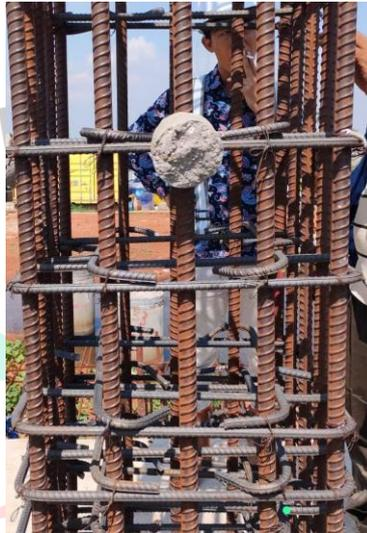
**Gambar 3. 63 Pemasangan Beton decking pada Tulangan Kolom**
