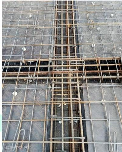
**Gambar 3. 42 Proses Pemasangan Tahu Beton**
