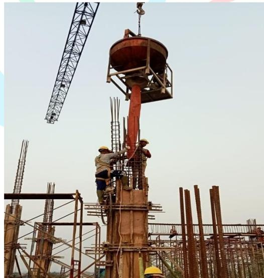
**Gambar 3. 66 Proses Penuangan Beton Segar Kolom**
