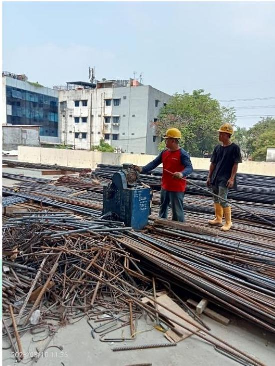
**Gambar 3. 36 Proses Pemotongan Besi**
