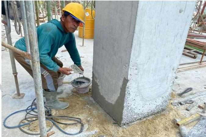
**Gambar 3. 71 Foto Segregasi Pada Kolom**
