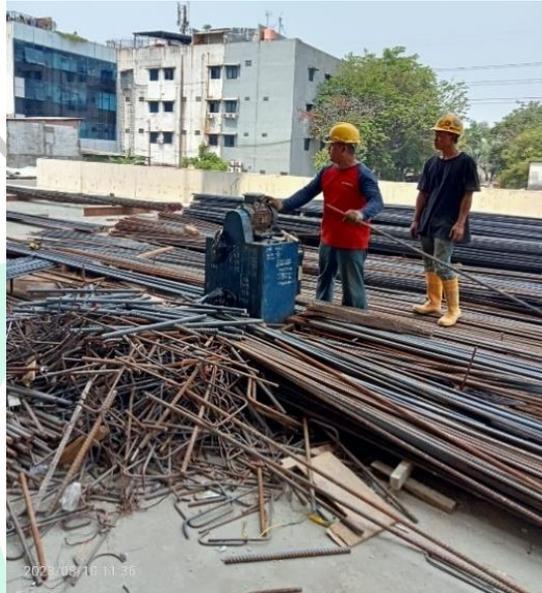
**Gambar 3. 57 Proses Pemotongan Besi**
