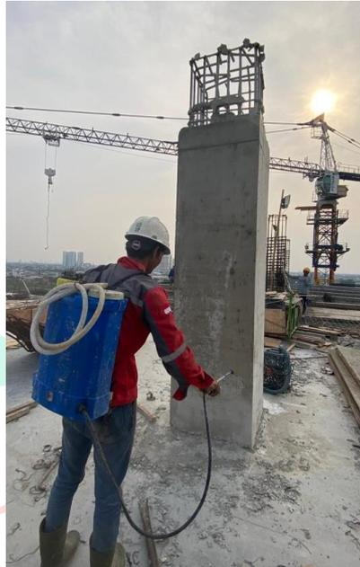
**Gambar 3. 54 Proses Perawatan Pelat Beton**
