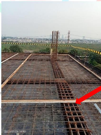
**Gambar 3. 43 Proses Pemasangan Relat Cor**
