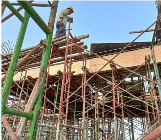
**Gambar 3. 40 Proses Perakitan Bekisting Balok Dan Pelat**
