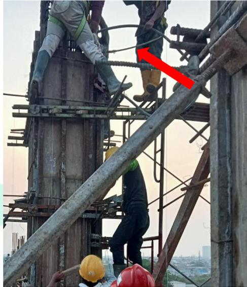
**Gambar 3. 67 Proses Pemadatan Beton Segar Pada Kolom**
