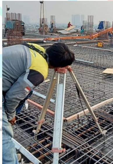
**Gambar 3. 62 Proses Presisi Tulangan Kolom**
