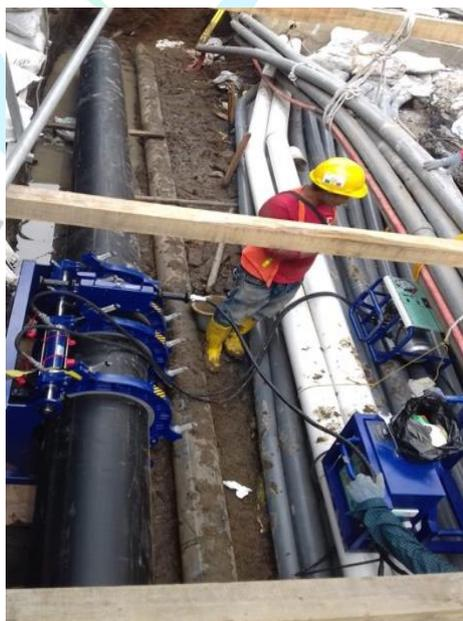
**Gambar 3. 36 Proses Penyambungan Pipa HDPE**
