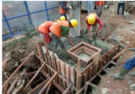
**Gambar 3. 43 Pembuatan Bekisting**
