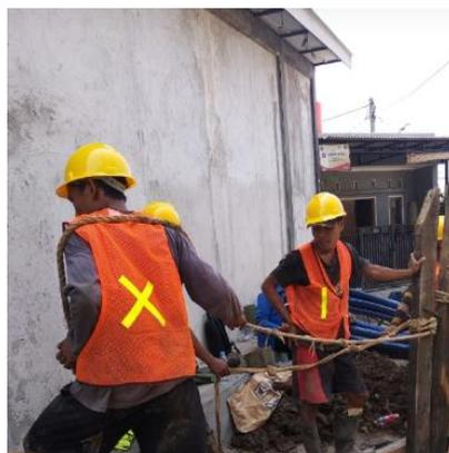
**Gambar 3. 38 Pekerjaan Boring Manual**
