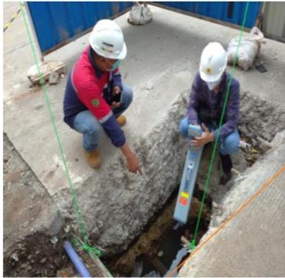
**Gambar 3. 34 Pekerjaan Test Pit**
