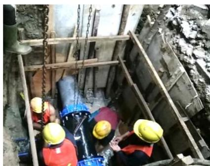
**Gambar 3. 40 Penyambungan Pipa Baru**
