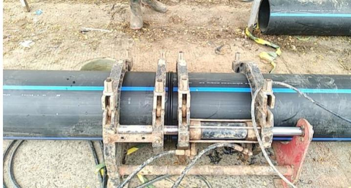
**Gambar 3. 37 Penyambungan Pipa HDPE**
