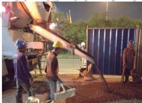
**Gambar 3. 45 Pengecoran**
