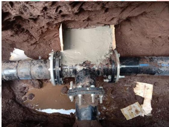
**Gambar 3. 41 Pembuatan Thrust Block**
