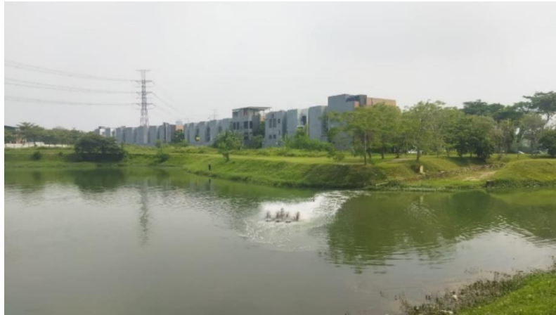
Gambar 4. 19 Aerator Turbin Sumber : Dokumentasi Penulis, 2024
