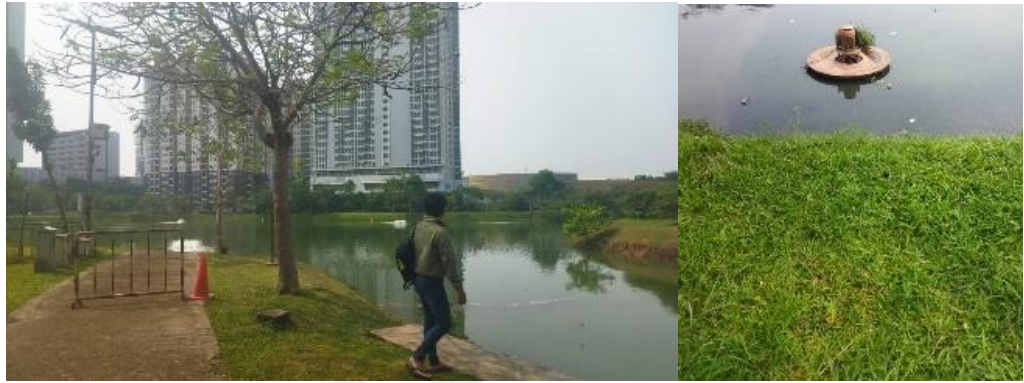
Gambar 4. 39 Kondisi Kebersihan Air dan Tanah Sumber : Dokumentasi Penulis, 2024
