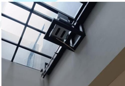
*Gambar 4. 9 Mesin Penggerak Skylight
