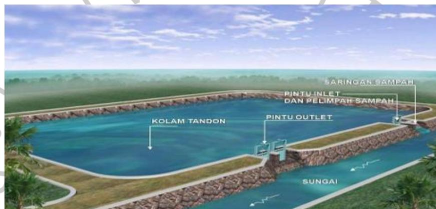
Gambar 2. 8 Kolam Retensi di Samping Badan Sungai (Kementerian PUPR, 2020)
