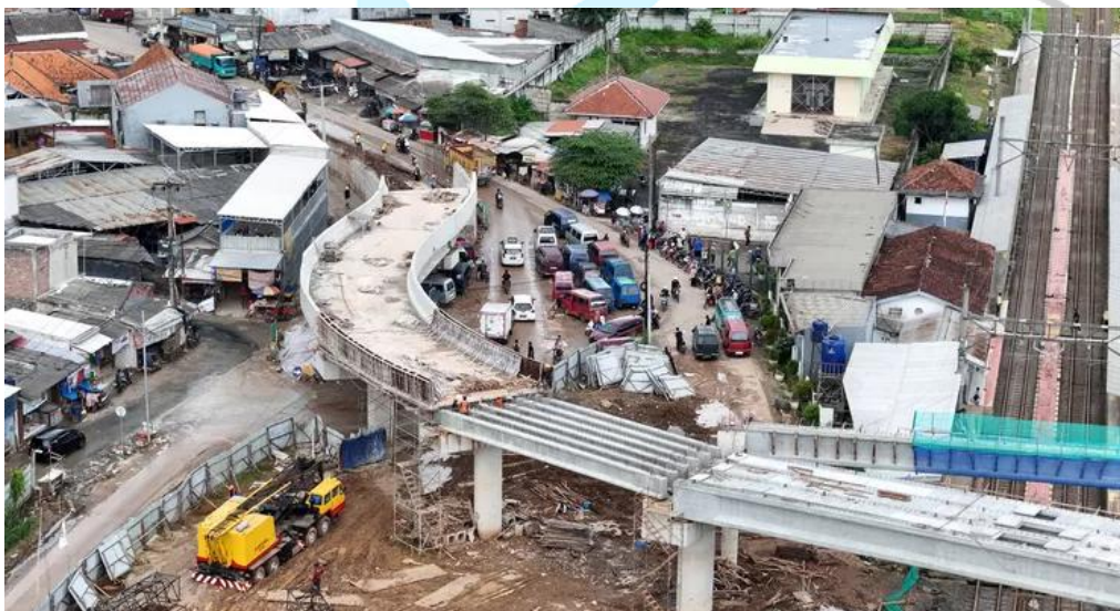
Gambar 4. 1 Pembangunan Flyover Di Tendjo, Kabupaten Bogor.
