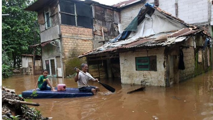
Gambar 1. 1 Kondisi Banjir Cawang Sumber: Detiknews
