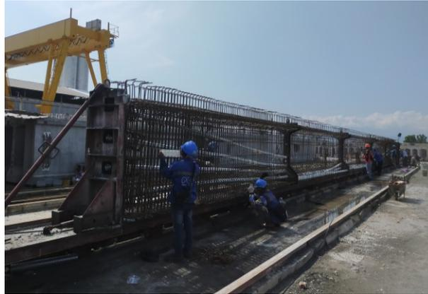
Gambar 4. 5 Pekerjaan Perakitan pada Meja Molding
