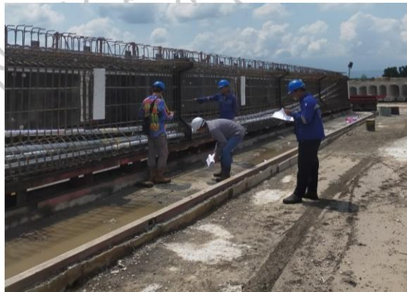
Gambar 4. 6 Pekerjaan Checklist Pembesian & Tendon
