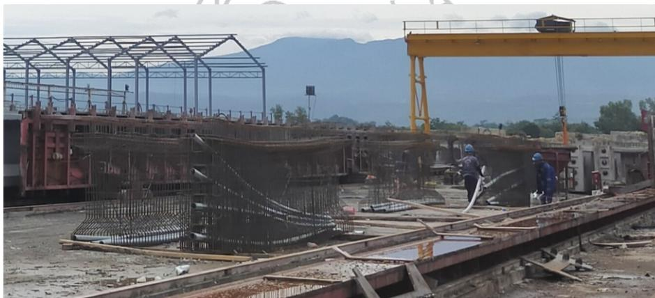
Gambar 4. 4 Pekerjaan pada *Stockyard* Pembesian
