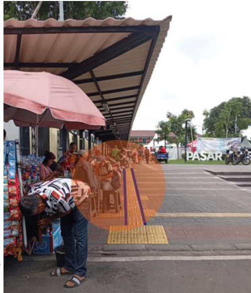
Gambar 1.4 Kondisi pedestrian akses Stasiun Pasar Senen (Sumber : Dokumentasi pribadi, 2025)
