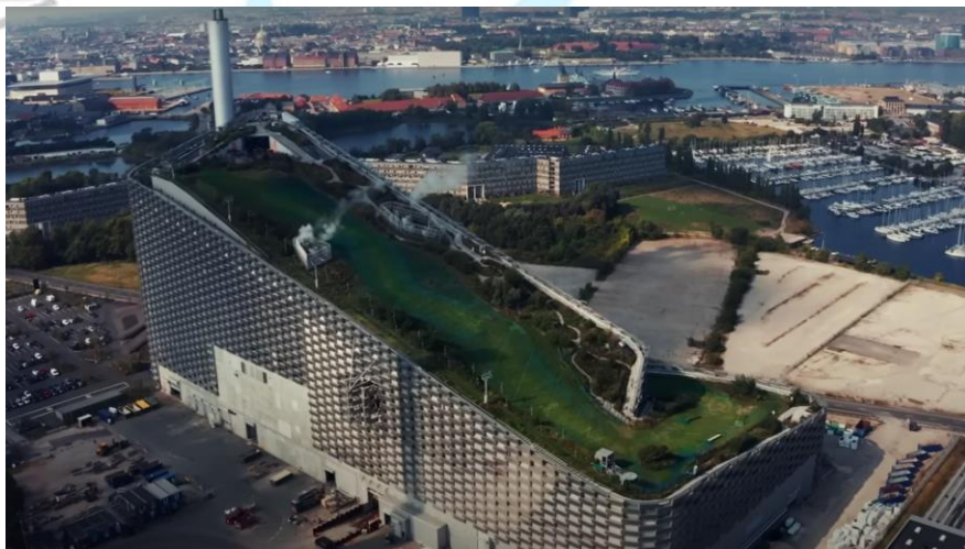
Gambar 2.12 Area Publik pada Copenhill (Sumber: Youtube.com/Architectural Digest, 2024)
