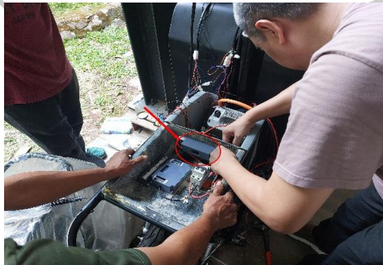
Gambar 4.16. Foto Instalasi Energy Meter pada e-cargo bike (1)
