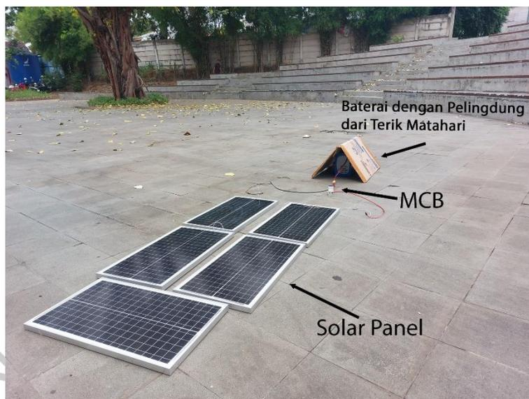
Gambar 5.8. Foto Charging Baterai menggunakan Solar Panel
