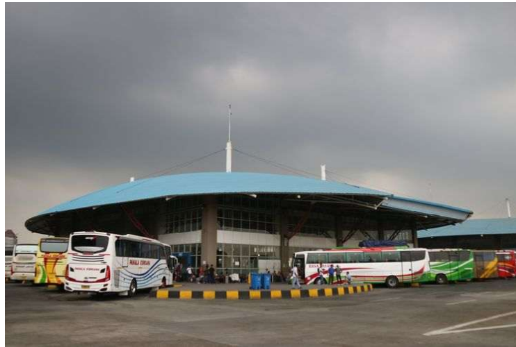
Gambar 2. 20 Terminal Terpadu Pulo Gebang Sumber : terminalpulogebang.com
