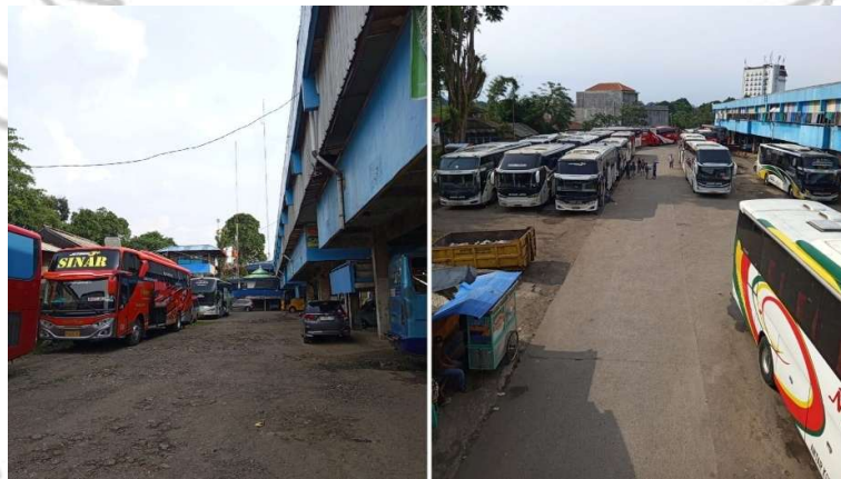
Gambar 1. 4 Eksisting Area Bus Sumber : Dokumentasi Pribadi, 2024
