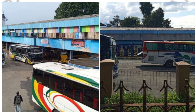
Gambar 1. 8 Fasad Terminal Baranangsiang Sumber : Dokumentasi Pribadi, 2024
