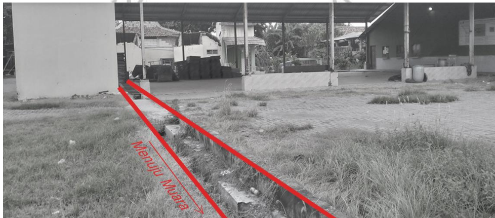
Gambar 3. 15 Drainase Pada Tapak Sumber: Dokumentasi Penulis, 2024
