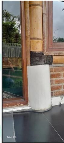
Gambar 4.3.2(a) Kolom Perkerasan dipasang pada Struktur Bambu
