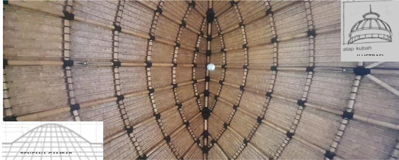
Gambar 4.3.3(a): Foto Konstruksi Anyaman bambu dari Dalam Masjid
