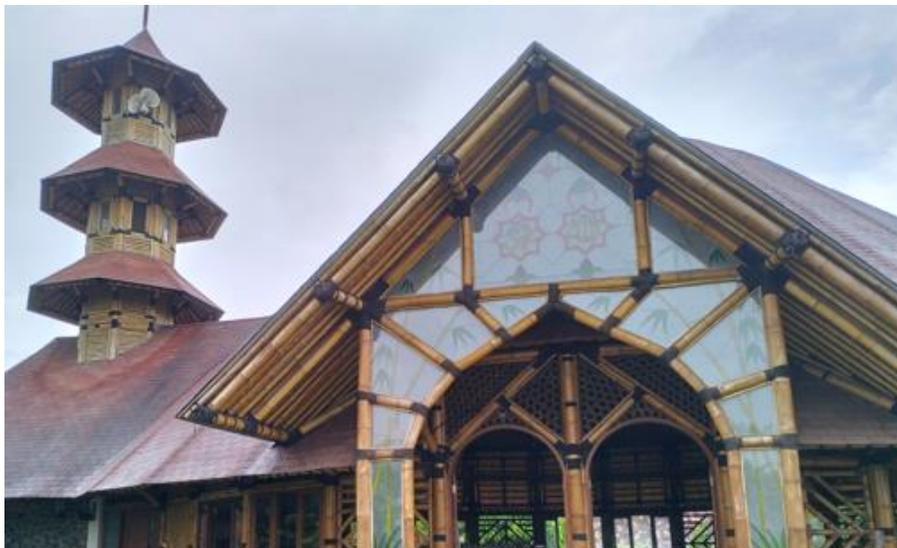
Gambar 4.2 (b) Contoh Konstruksi Bahan Bambu pada Area Pintu Depan Masjid
