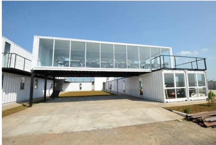
Gambar 2. 1 PCI Container Office Cilegon Sumber: Foto Proyek MjBarchitects
