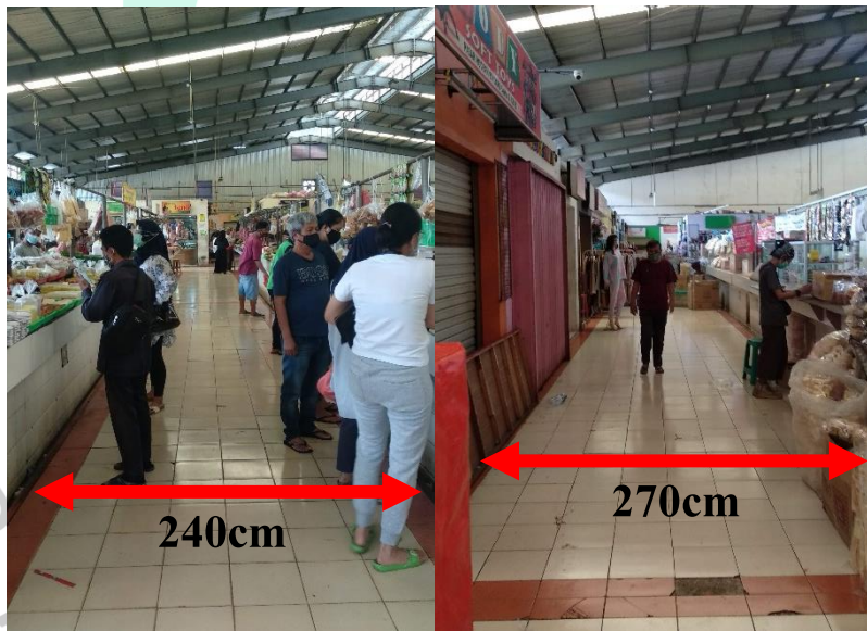
Gambar 4.23 Suasana Koridor antar Lapak dan Lapak dengan Kios Pasar Modern Bintaro (Penulis, 2020)
