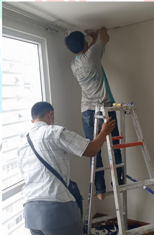
Gambar 3.11 Pengawasan Pekerjaan Unit Yang Bocor di Ruang Tidur
