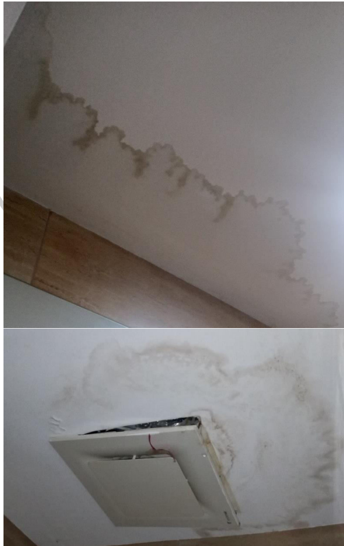
Gambar 3.6 Pengecekan Unit Plafond Kamar Mandi Bocor
