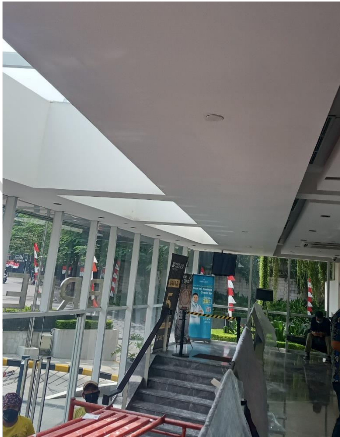
Gambar 3.16 Dokumentasi Pekerjaan Perbaikan Plafond Lobby Tower Breeze yang Telah Selesai
