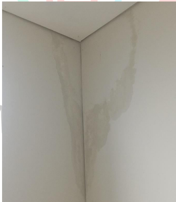
Gambar 3.4 Pengecekan Unit Balkon Rembes
