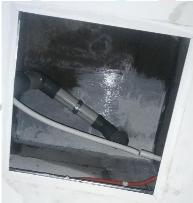
Gambar 3.12 Pengawasan Pekerjaan Unit Yang Bocor di Kamar Mandi
