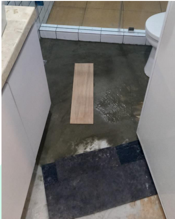
Gambar 3.9 Pengecekan Unit yang Menjadi Sumber Kebocoran
