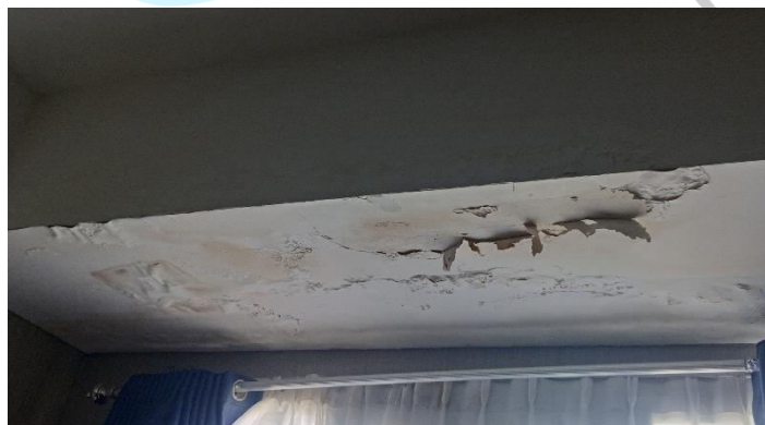
Gambar 3.6 Pengecekan Unit Plafond Kamar Mandi Bocor
