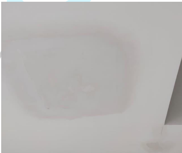
Gambar 3.17 Dokumentasi Pekerjaan Perbaikan Plafond Unit yang Telah Selesai
