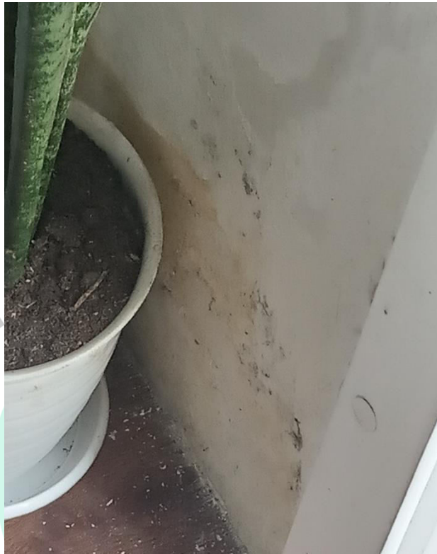
Gambar 3.4 Pengecekan Unit Balkon Rembes
