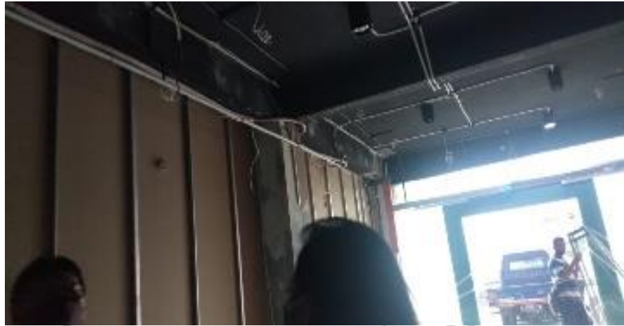
Gambar 3.3 Pelaksanaan Kerja Proyek ke-1
