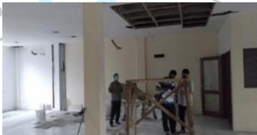
Gambar 3.2 Pelaksanaan Kerja Proyek ke-1
