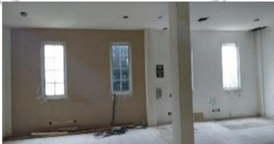
Gambar 3.4 Pelaksanaan Kerja Proyek ke-1
