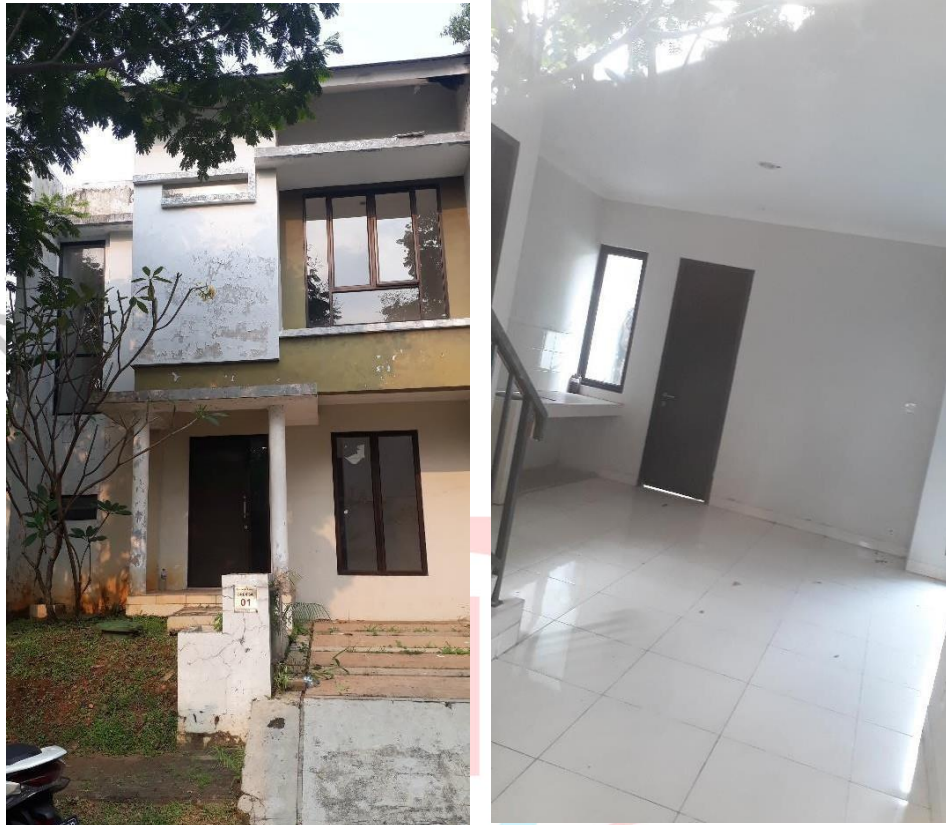
Gambar 3.16 Tampak depan Neo Gardenia dan keadaan rumah blok GRB F6A-01 Sumber : Praktikan, 2021
