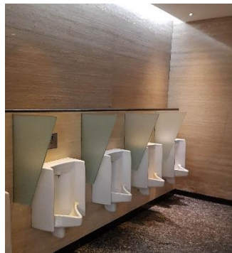
Gambar 1.4 Toilet Plaza Indonesia Sumber: Dokumentasi Pribadi, 2018
