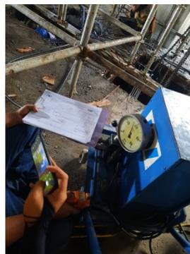
**Gambar 3.41 Proses Pengecekan Elongasi**
