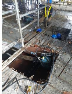
**Gambar 3.27 Pembuatan *Stressing Pocket***
