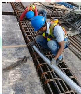
**Gambar 3.23 Proses Instalasi Duct ke Dalam Balok**
