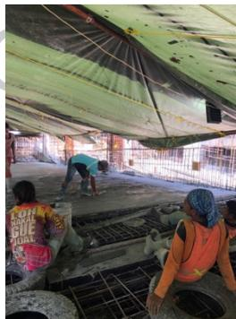
**Gambar 3. 48 Pemasangan Terpal Sebagai Tenda di Area Ramp**
