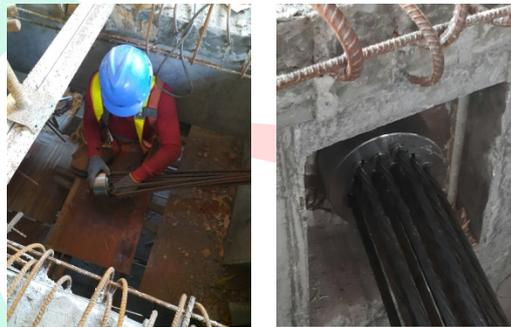
**Gambar 3.36 Pemasangan *Wedges* dan Angkur *Head* pada *Strand***
