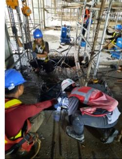
**Gambar 3.39 Simulasi dan Proses Pengecekan Elongasi**
