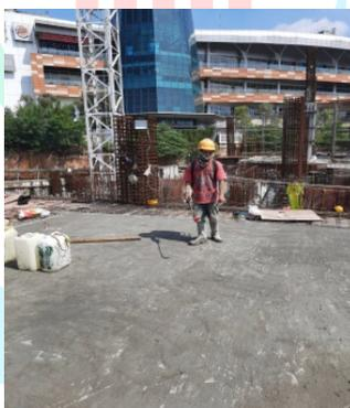
**Gambar 3.7 Pekerjaan *Curing* Beton Lantai**
