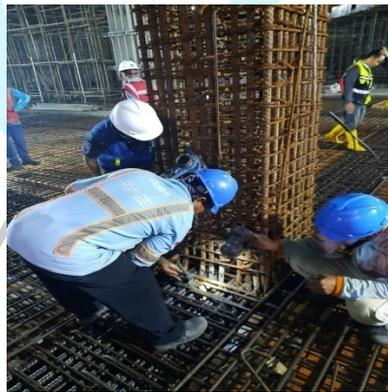
**Gambar 3.4 Pengecekan Pembesian dan Sapot Bar**
