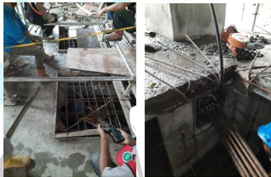
**Gambar 3.35** Proses Pembuatan *Stressing Pocket*
