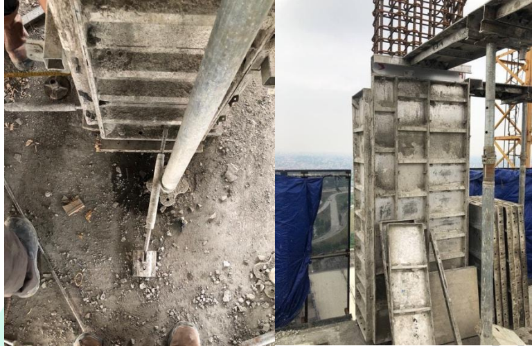
Gambar 3. 9 Bekisting Kolom
