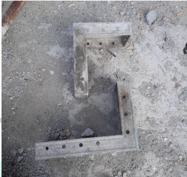
Gambar 3. 4 Pelat lantai Incorner dan Outcorner
