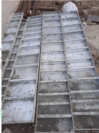
Gambar 3. 2 Wall, Pelat lantai dan Bottom Panel
