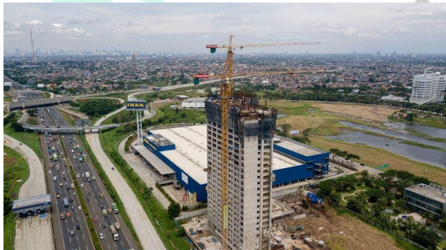
Gambar 3. 1 Progress Proyek (Data Proyek)
