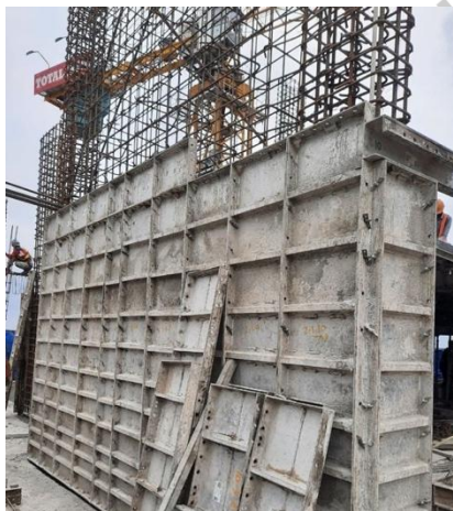
Gambar 3. 10 Bekisting Dinding Geser
