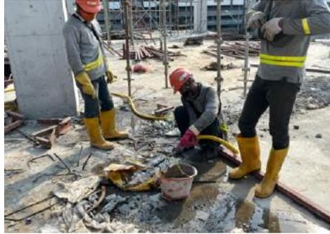
Gambar 3.58 *Grouting Mix* Tidak Mengalir
