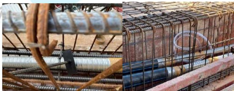
**Gambar 3.47 Kapler dan Grouting Vent Installation**
