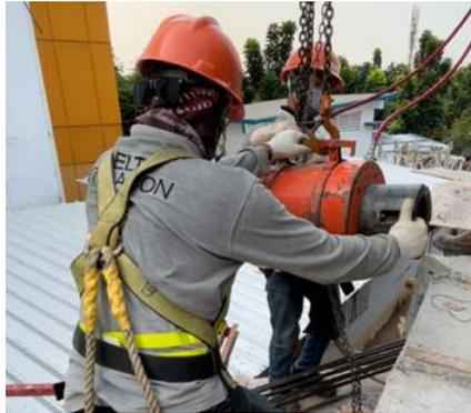
Gambar 3.53 Pemasangan Hydraulic Jack
