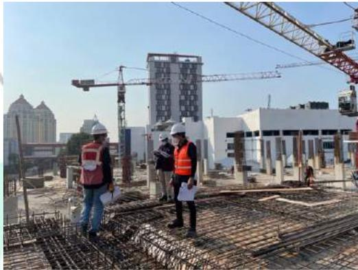
**Gambar 3.3 Pengawasan pada Pekerjaan Balok dan Plat**
