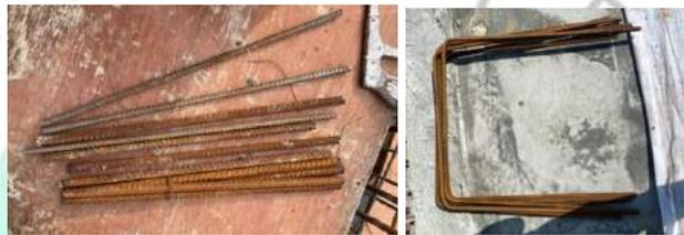
Gambar 3.24 *Support Bar* dan *Capping Link*
