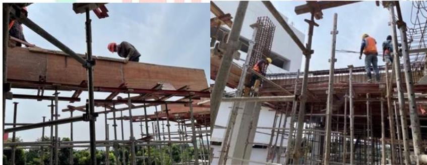
**Gambar 3.39 Pemasangan Bekisting *Plywood* dan Pembesian**
