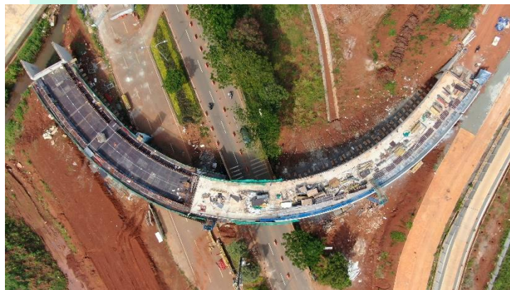
Gambar 3. 46 Pengalihan Lalu Lintas di Box Girder Ramp D2 Sumber: Dokumen PT. Wijaya Karya (Persero) Tbk
