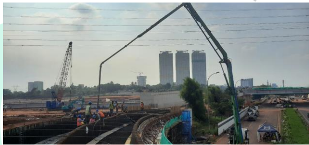
Gambar 3. 35 Proses Penuangan Beton menggunakan Concrete Pump
