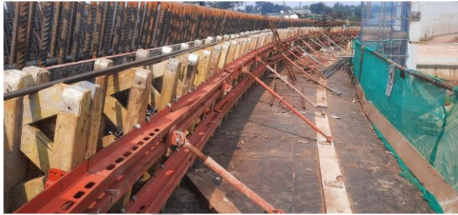
Gambar 3. 15 Sistem Bekisting PERI
