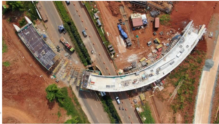
Gambar 3. 45 Pengalihan Lalu Lintas di Box Girder Ramp C2 Sumber: Dokumen PT. Wijaya Karya (Persero) Tbk
