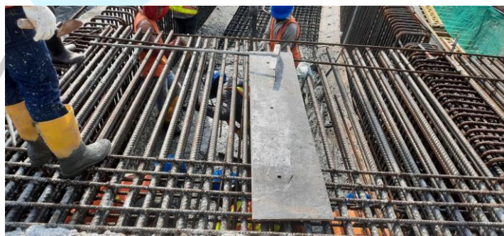
Gambar 3. 36 Pemadatan Beton menggunakan Vibrator Elektrik
