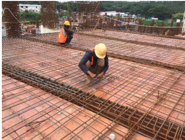
Gambar 3.10 Pekerjaan Pembesian Plat Lantai
