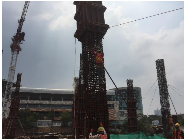
Gambar 3.14 Pemasangan Bekisting Kolom
