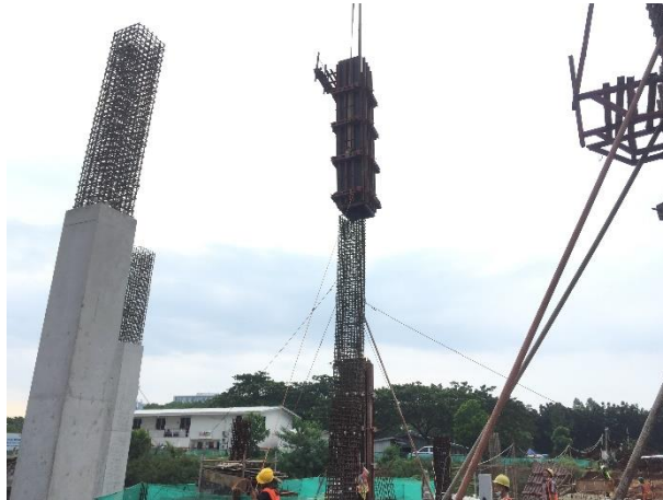
Gambar 3.13 Penepatan Bekisting Kolom Menggunakan Tower Crane
