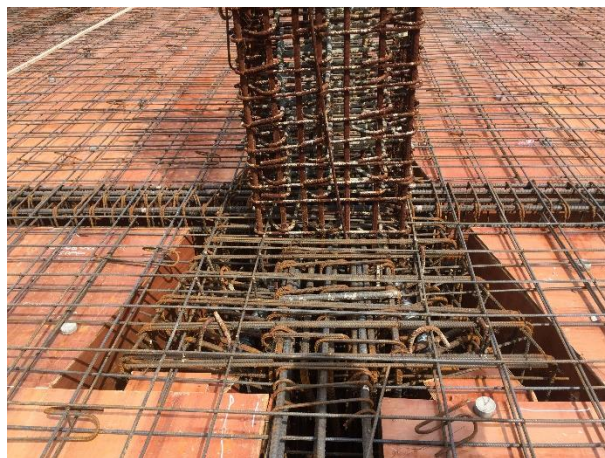
Gambar 3.9 Pekerjaan Pembesian Balok
