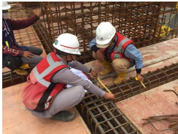
Gambar 3.12 Pengecekan Pembesian Balok dan Plat Lantai
