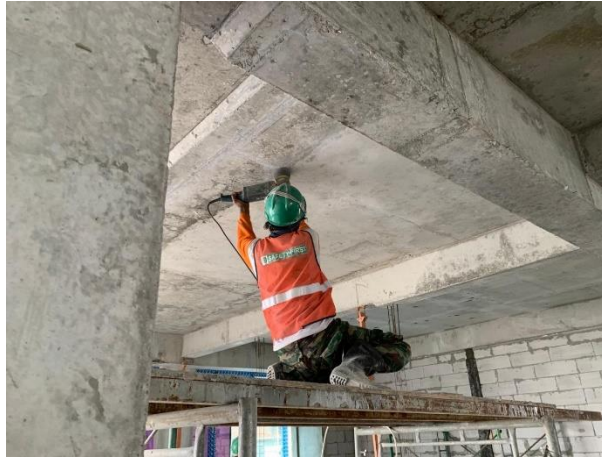
Gambar 3.35 Proses Penghalusan Beton Plat Slab
