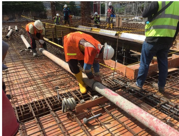
Gambar 3.14 Pemasangan Pipa dari Fixed Concrete Pump
