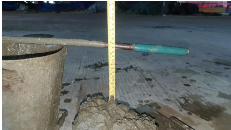
Gambar 3.13 Pengecekan SlumpTest Balok dan Plat Lantai
