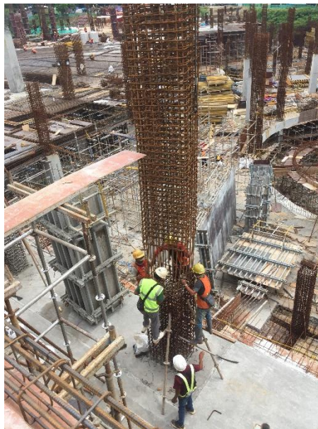
Gambar 3.10 Penyambungan Kolom Vertikal
