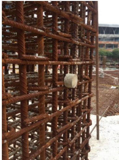
Gambar 3.11 Pemasangan Decking Beton
