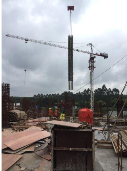
Gambar 3.9 Tulangan Kolom yang Diangkut TC
