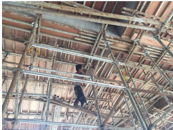
Gambar 3.32 Pelepasan Bekisting Balok dan Pelat Lantai
