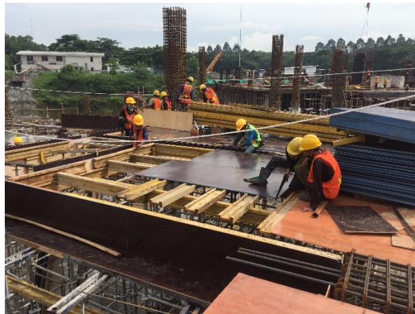
Gambar 3.82 Bekisting Balok dan Plat
