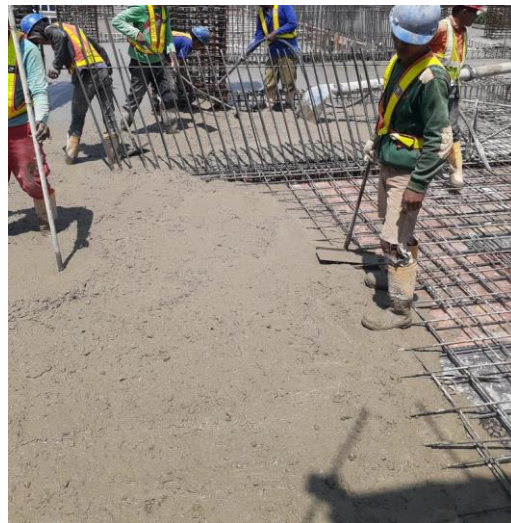
Gambar 3.31 Pengecoran Balok dan Pelat Lantai
