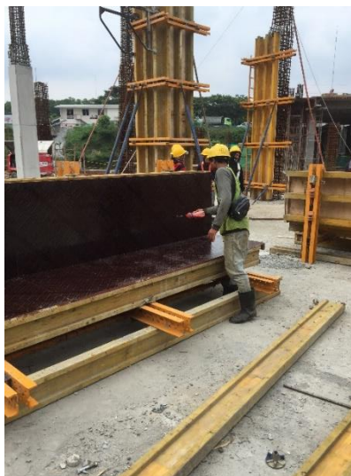
Gambar 3.12 Pekerjaan Bekisting Kolom
