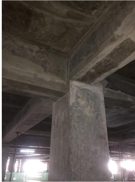
Gambar 3.33 Pelepasan Bekisting Balok dan Pelat Lantai
