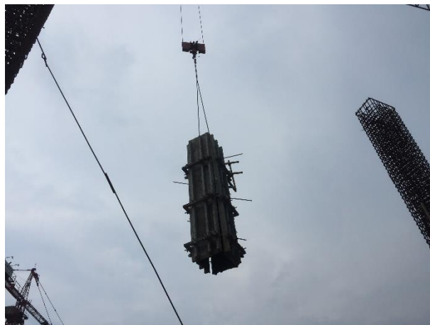
Gambar 3.18 Pelepasan Bekisting Kolom
